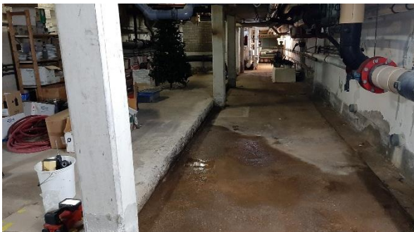
01] Aanzicht van de kolommen in de kelderruimte
