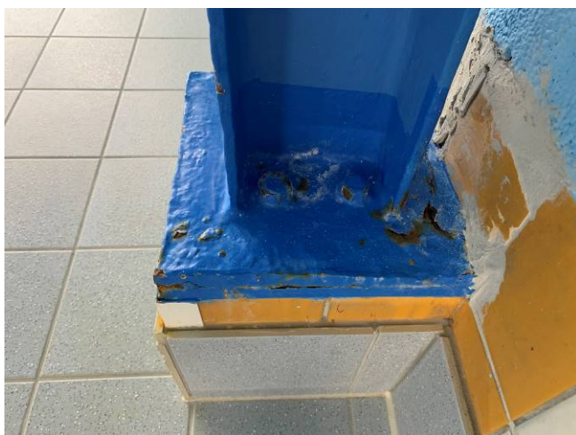
Sterk aangetaste kolomvoet op as F28
