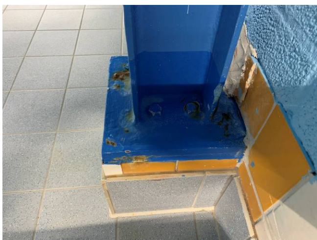
Sterk aangetaste kolomvoet op as E28
