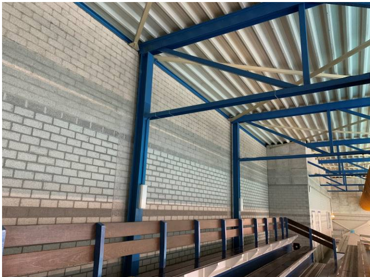
Kolommen vakwerkspanten as C achter de zittribune
