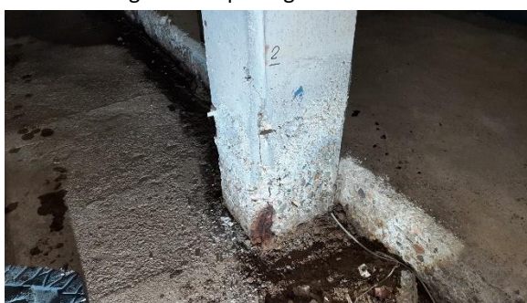
10-11] Aanzicht onderzijde kolom 2. Het schadebeeld aan de onderzijde van kolom 2 is vergelijkbaar met kolom 1. De schade [holklinkende betondekking] manifesteert zich met name in de betondekkingszone. Dieper gelegen beton vertoont een goede samenhang. De hoofdwapening \varnothing 12 en beugelwapening \varnothing 8 is oppervlakkig gecorrodeerd met plaatselijk enige staafreductie. De carbonatatiediepte is circa 20 tot 25 mm.
