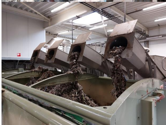
Roostergoedpersinstallatie en -verlading vervangen
