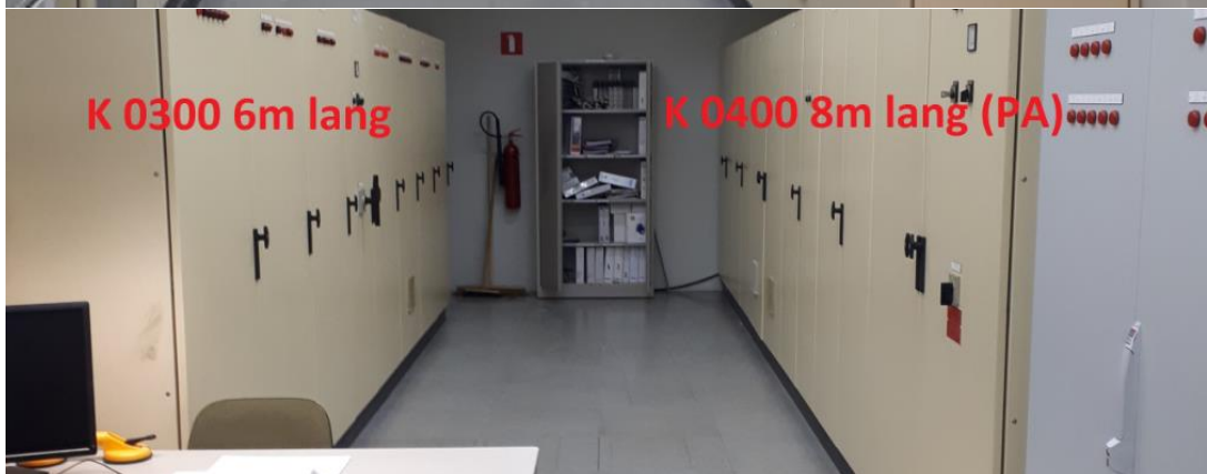
E schakelruimte vervangen panelen
