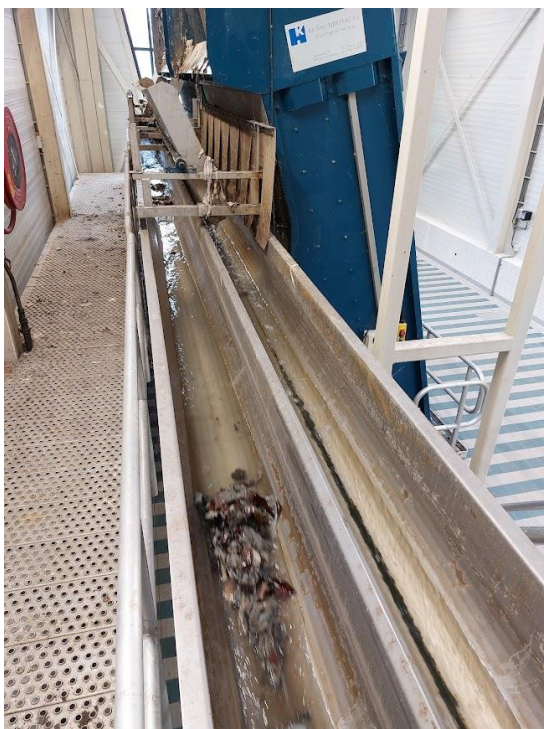
Glijgoten hergebruik / renoveren / vervangen / amoveren
