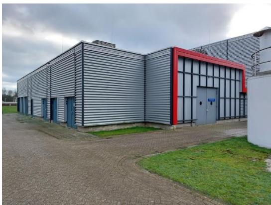
Influentgemaal buiten geen geplande werkzaamheden
