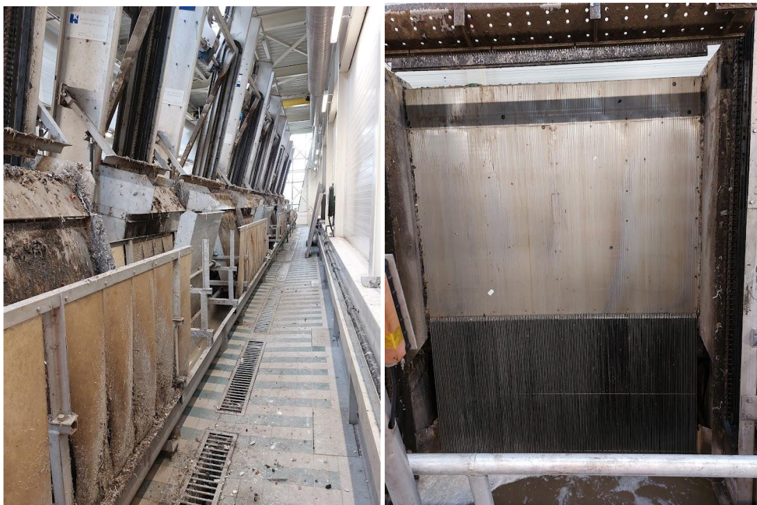
Fijnroosterinstallatie reviseren en voorzien van omkasting
