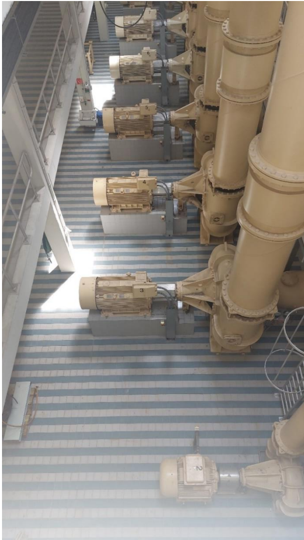
Afbeelding 3: Pompen influentgemaal RWZI Eindhoven.
