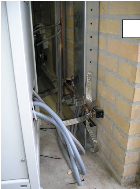
Foto 007, aardraaitje buiten de kast als EMC-interface gelijkrichter; RH10 Bostel voorjaar 2009
