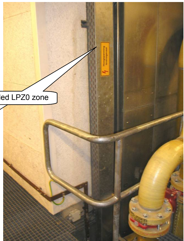
foto 8. Praktijk, tracé hoogspanningskabels Botlek tunnel, van tunnelbuisniveau naar begane grond
