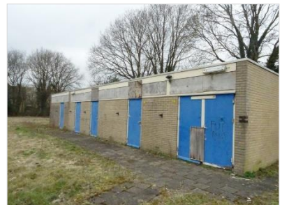
Figuur 2.5 Kleedruimtes met plat dak.
