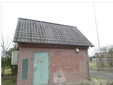
Figuur 2.6 Elektriciteitshuisje met pannendak.
