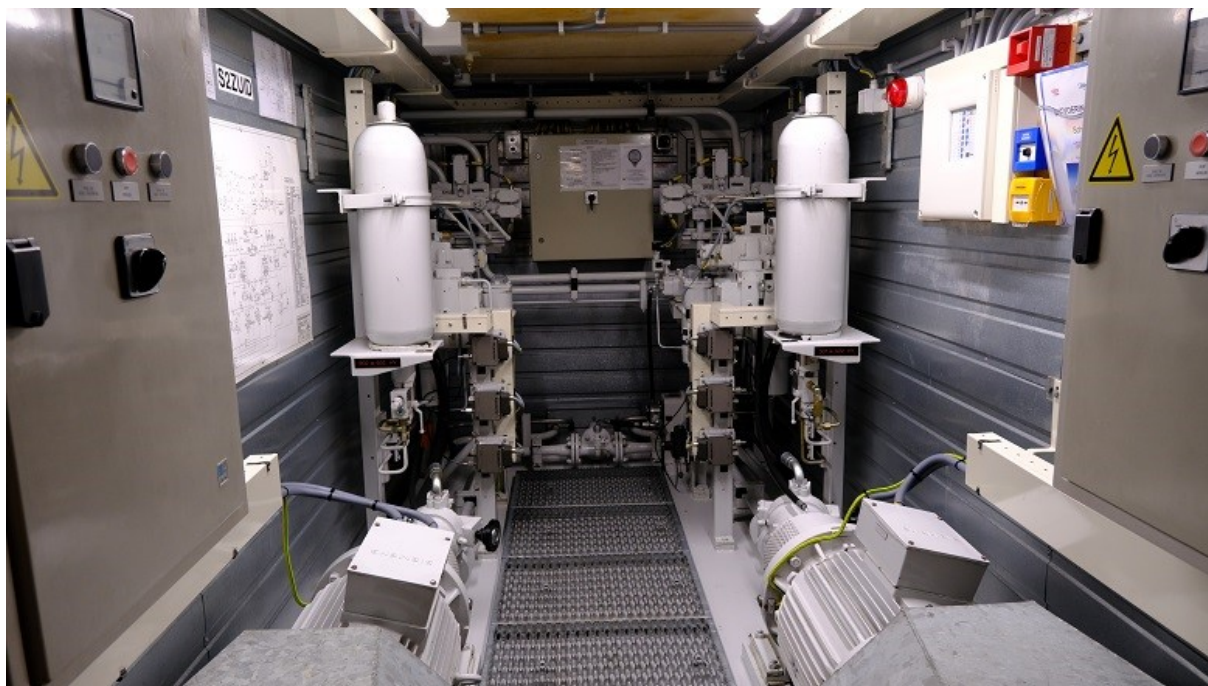
OBT-00089 Elektro-hydraulische aandrijfeenheid ( EH-eenheid ), Substelsiem
