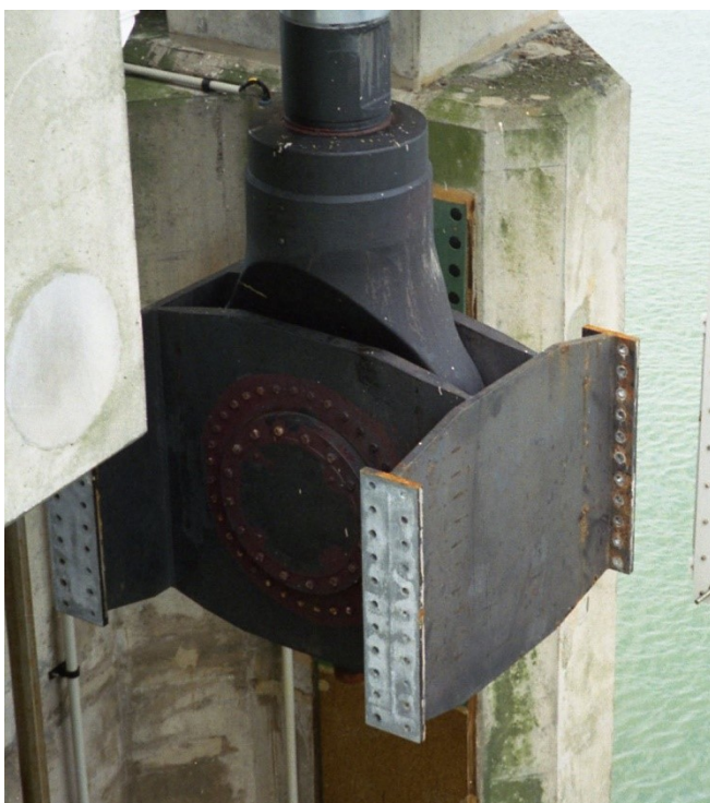
OBT-00087 Overgangsconstructie van het onderoog / Staalconstructie onderoog
