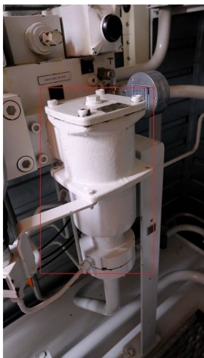
OBT-00096 oliefilters in de container van de EH-eenheid
