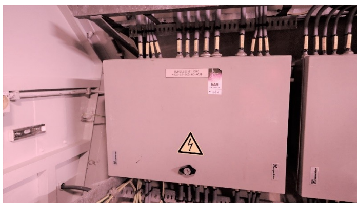
OBT-00148 Bliksembeveiliging Substelsiem
