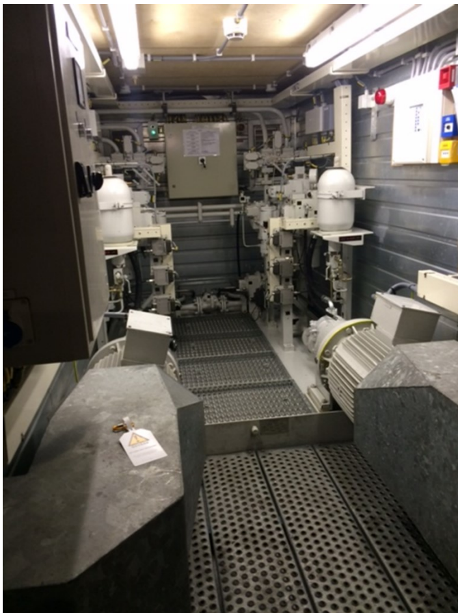
OBT-00092 hydraulisch Aggregaat in de container van de EH-eenheid
