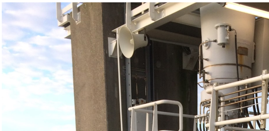
OBT-00035 Pijleromroep-installatie
