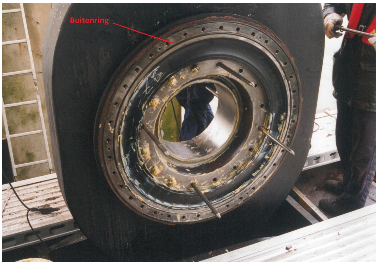
OBT-00084 Buitenring van de onderooglagerafdichting
