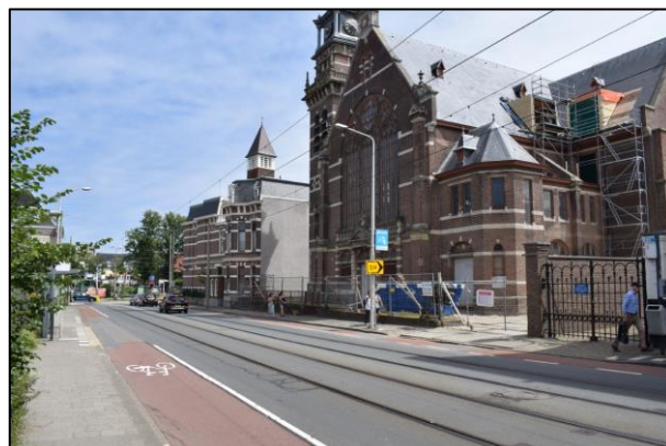
Foto 2: Duinstraat, gezien in oostelijke richting met de wegvakken 1 en 2 (rijbanen), 3 ('Duinstraat noordelijke fietsstrook 1') en 7 ('Duinstraat zuidelijke fietsstrook 1')
