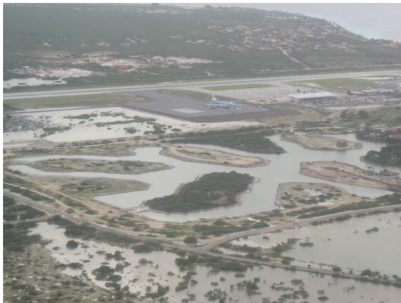
Afbeelding 4 Luchtfoto passage Ivan 2004
