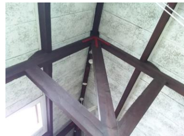
Overzicht rode spantanker zolder
