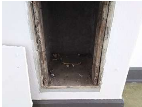
In koven en schachten geen asbestverdacht materiaal aangetroffen.
