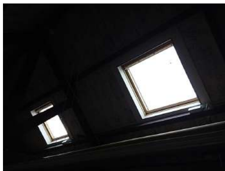
Velux dakramen niet asbestverdacht.
