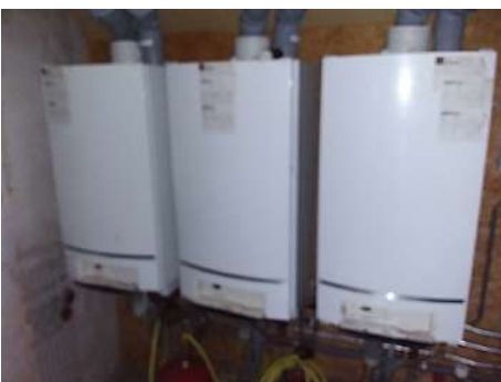
CV ketels zijn niet asbestverdacht.
