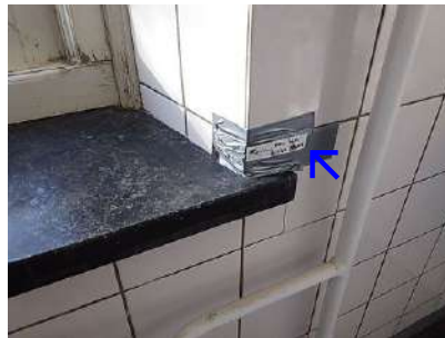
foto: lijmlaag - toilet
