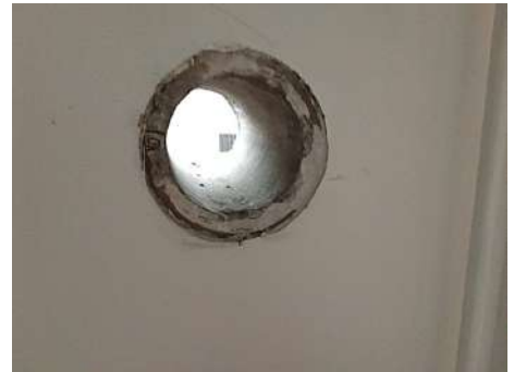
In muur doorvoer geen asbestverdacht materiaal aangetroffen.
