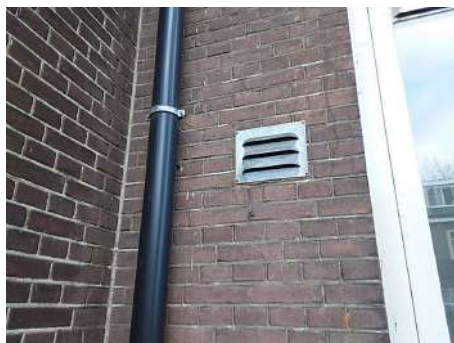
Geen asbestverdacht materiaal in geveldoorvoer aangetroffen.
