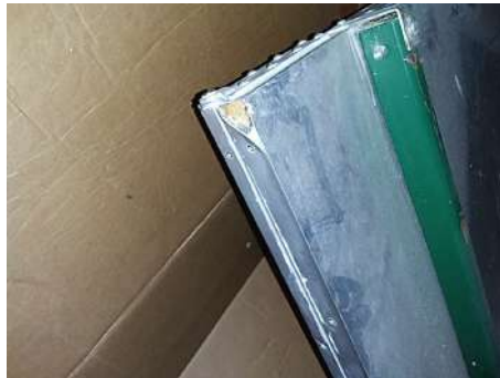
In schoolborden geen asbestverdacht materiaal aangetroffen.
