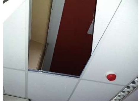
Boven systeemplafond geen asbesthoudend materiaal aangetroffen.
