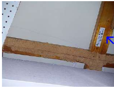
foto: lijmlaag - Trappenhuis
