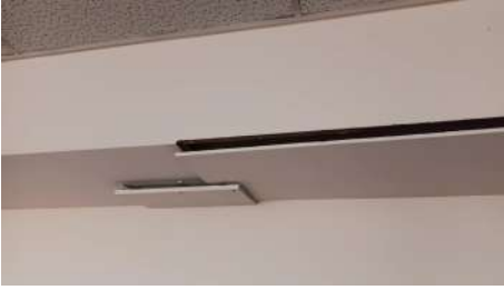
Koof geopend, geen asbestverdacht materiaal.
