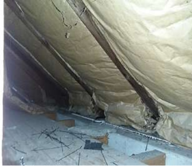
Glaswol isolatie tussen Heraklith beplating en houten dakbeschoot niet asbestverdacht.
