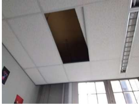
Boven systeemplafond geen asbesthoudend materiaal aangetroffen.
