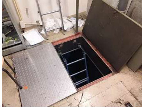
Luik liftmachinekamer niet asbestverdacht.
