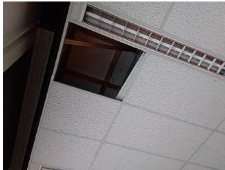
Boven systeemplafond geen asbesthoudend materiaal aangetroffen.
