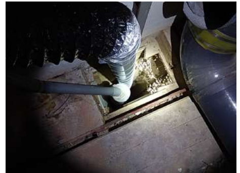
Geen asbestverdacht materiaal in schacht.
