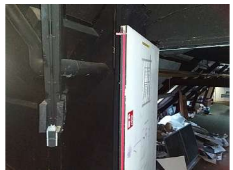
Branddeuren zijn niet asbestverdacht.
