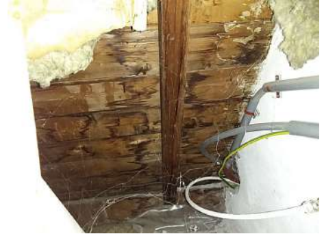
Houten dakbeschoot achter glaswol isolatie niet asbestverdacht.
