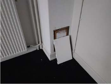
Geen asbestverdacht materiaal in schacht.
