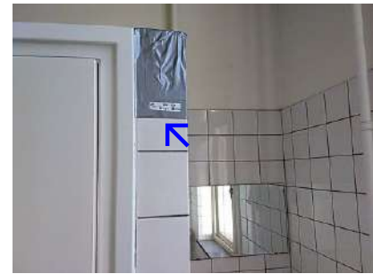
foto: lijmlaag - toilet
