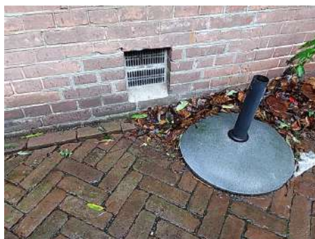
In ontluchtingen kruipruimte geen asbestverdacht materiaal aangetroffen.
