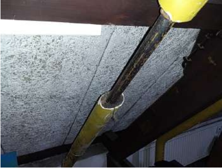
Leiding isolatie in het gebouw is niet asbestverdacht.
