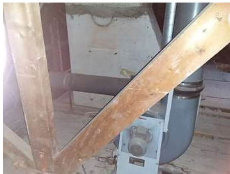
Ventilatie systeem niet asbestverdacht.
