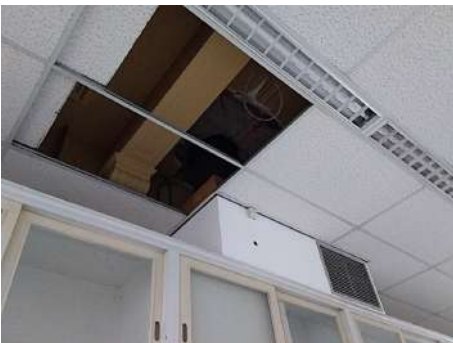
Oud rietstuc plafond boven systeemplafond.
