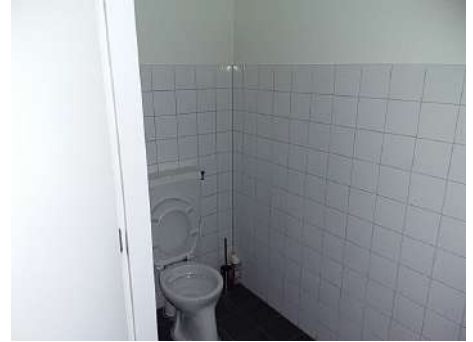
Toiletgroep met niet asbestverdachte tegellijm, na 1994 gebouwd.
