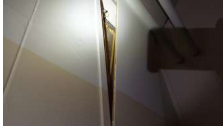
Koof geopend, geen asbestverdacht materiaal.
