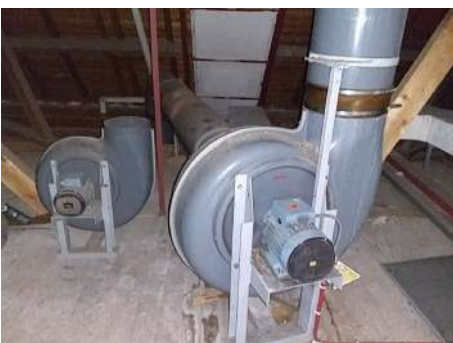
Ventilatie systeem niet asbestverdacht.
