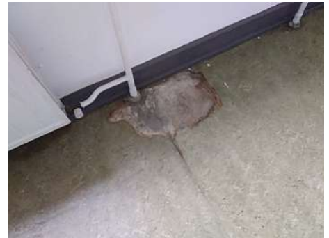
Onder vaste vloer bedekkingen, geen asbestverdacht materiaal aangetroffen.
