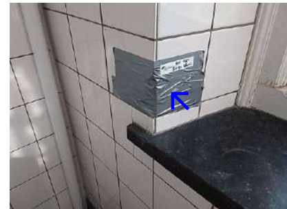
foto: lijmlaag - toilet
