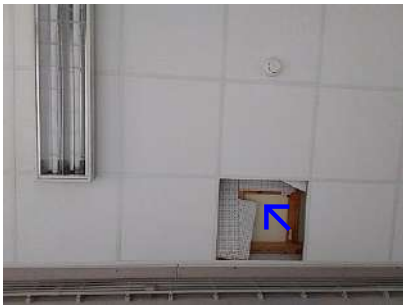
foto: lijmlaag - Trappenhuis
