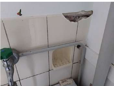
Wandtegels in cement gezet, niet asbestverdacht.
