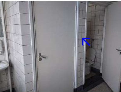
foto: lijmlaag - toilet
