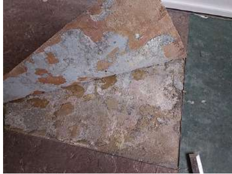
Onder vaste vloerbedekkingen geen asbestverdacht materiaal aangetroffen.
