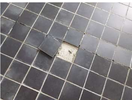
Vloertegels in cement gezet, niet asbestverdacht.
