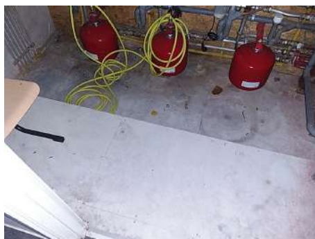
Brandwerende beplating in het gebouw is niet asbestverdacht.
