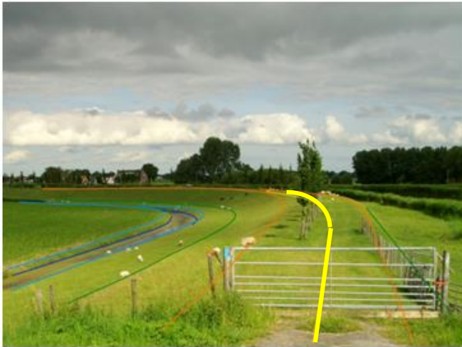
Figuur 8-37: Ligging van midden kruinlijn (geel) geprojecteerd over de kering. De overige zichtbare lijnen zijn kenmerkende profiellijnen (zie § 10.5)
