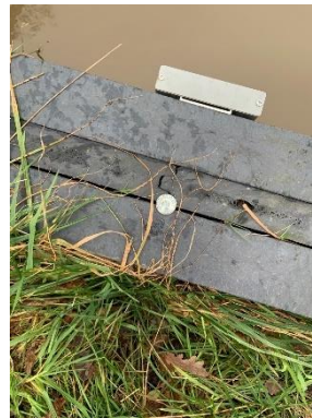
Figuur 9-5: Meetspijker niet in plank of balk geboord en gekit maar in de naad geslagen - kans op vriezen.
