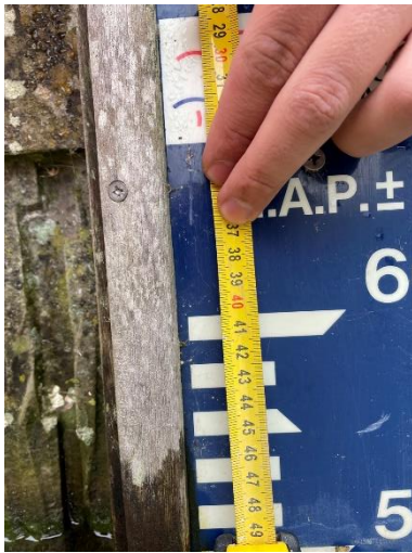
Figuur 9-9: Aflezing rolmaat bovenkant niet zichtbaar - hierdoor geen controle mogelijk met hulppunt.
