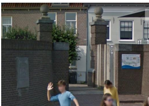
Coupure Wijk bij Duurstede (schuifdeur en 2 sponningen)
