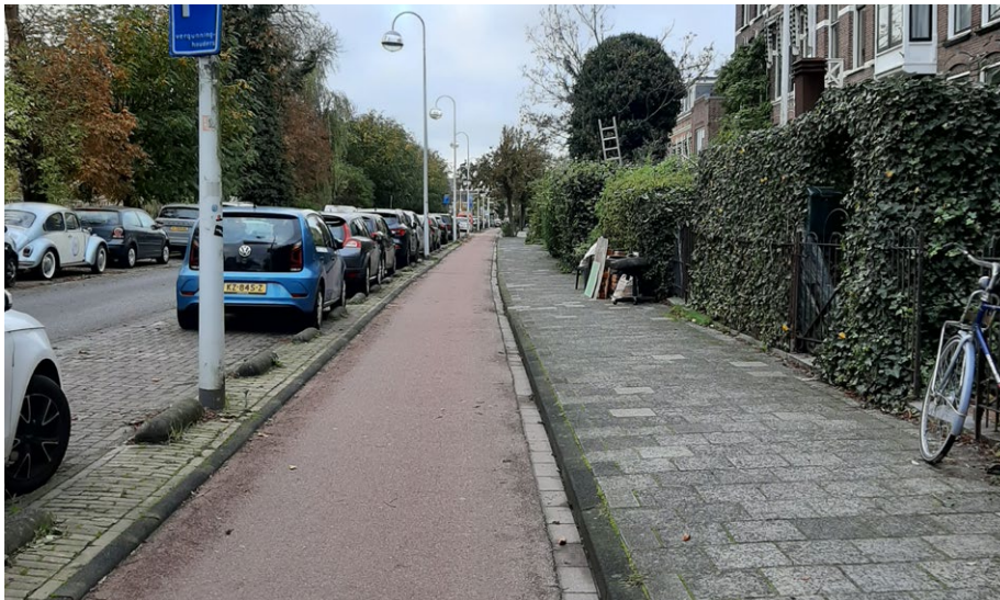
Trottoirtegels in het trottoir, asfalt in het fietspad
