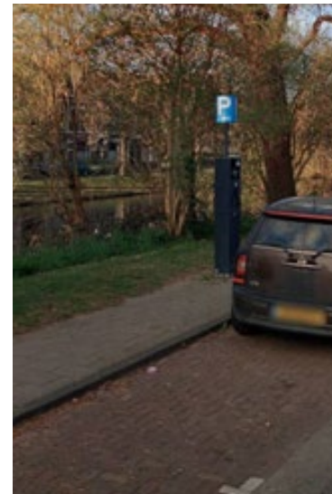
Gebakken klinkers in de parkeervakken
