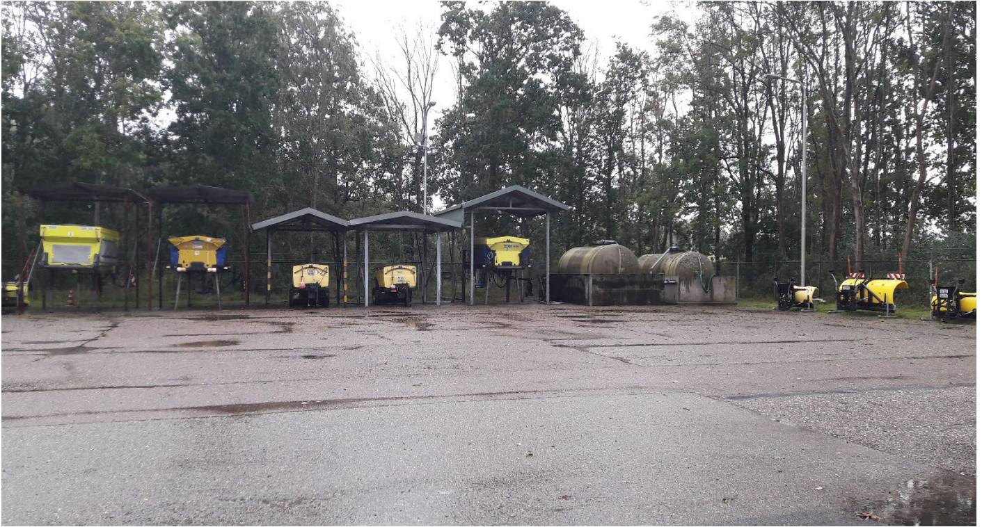
Afbeelding 1.3.7: zicht oostzijde; materieelstalling en buffertanks
