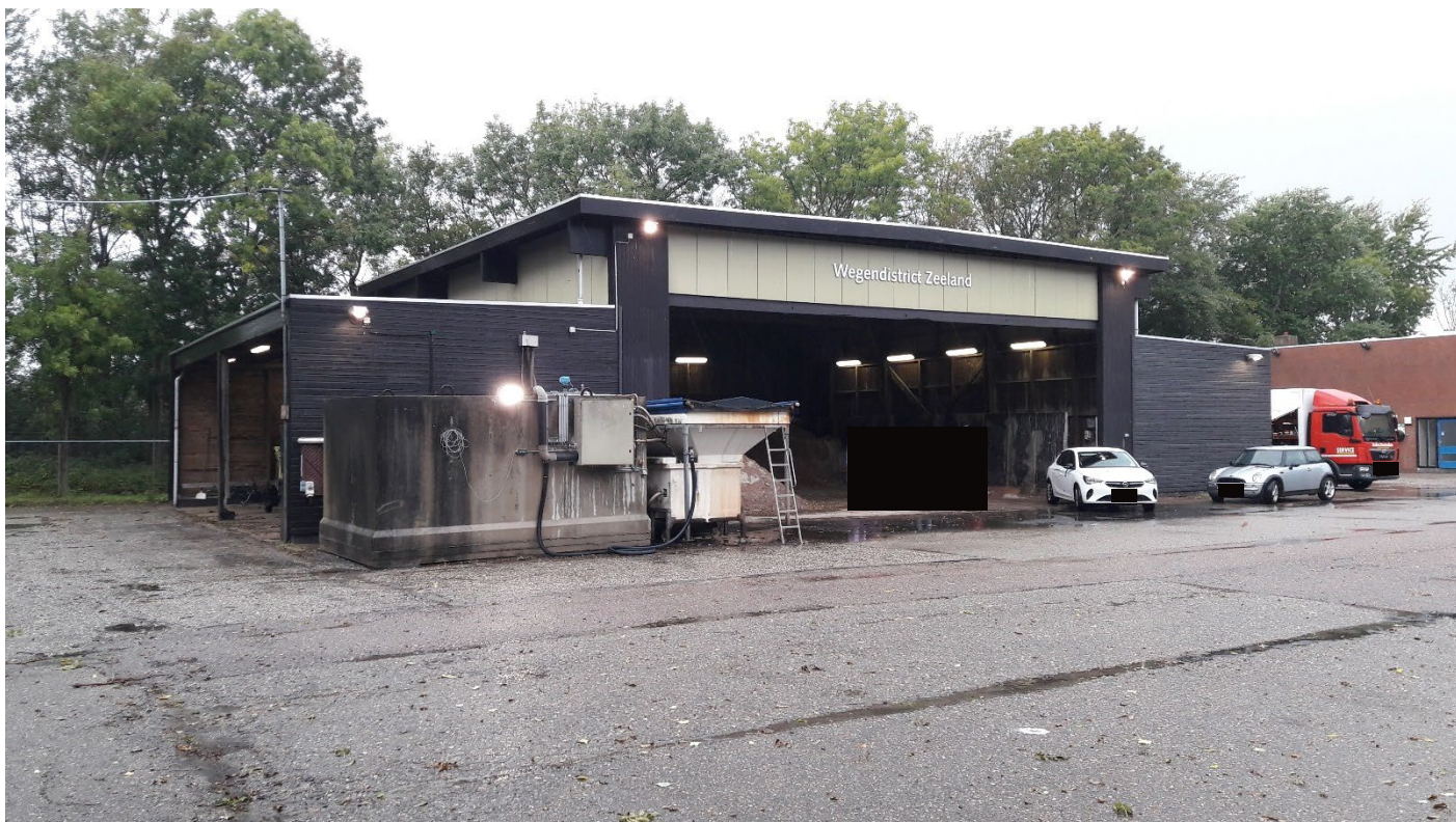
Afbeelding 1.3.9: zicht westzijde; zoutloods met overkappingen tbv materieel
