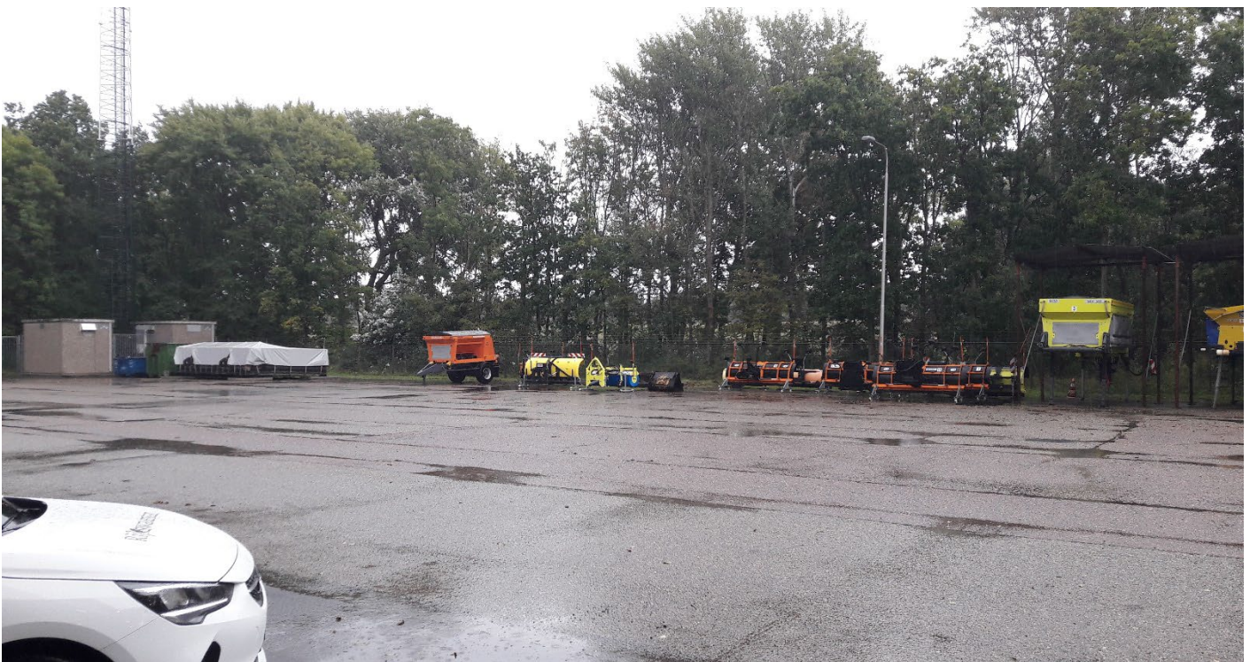
Afbeelding 1.3.4: zicht noordoosthoek; gebouwen zendmast (buiten scope), opslagplaats sluisdeur, materieelstalling
