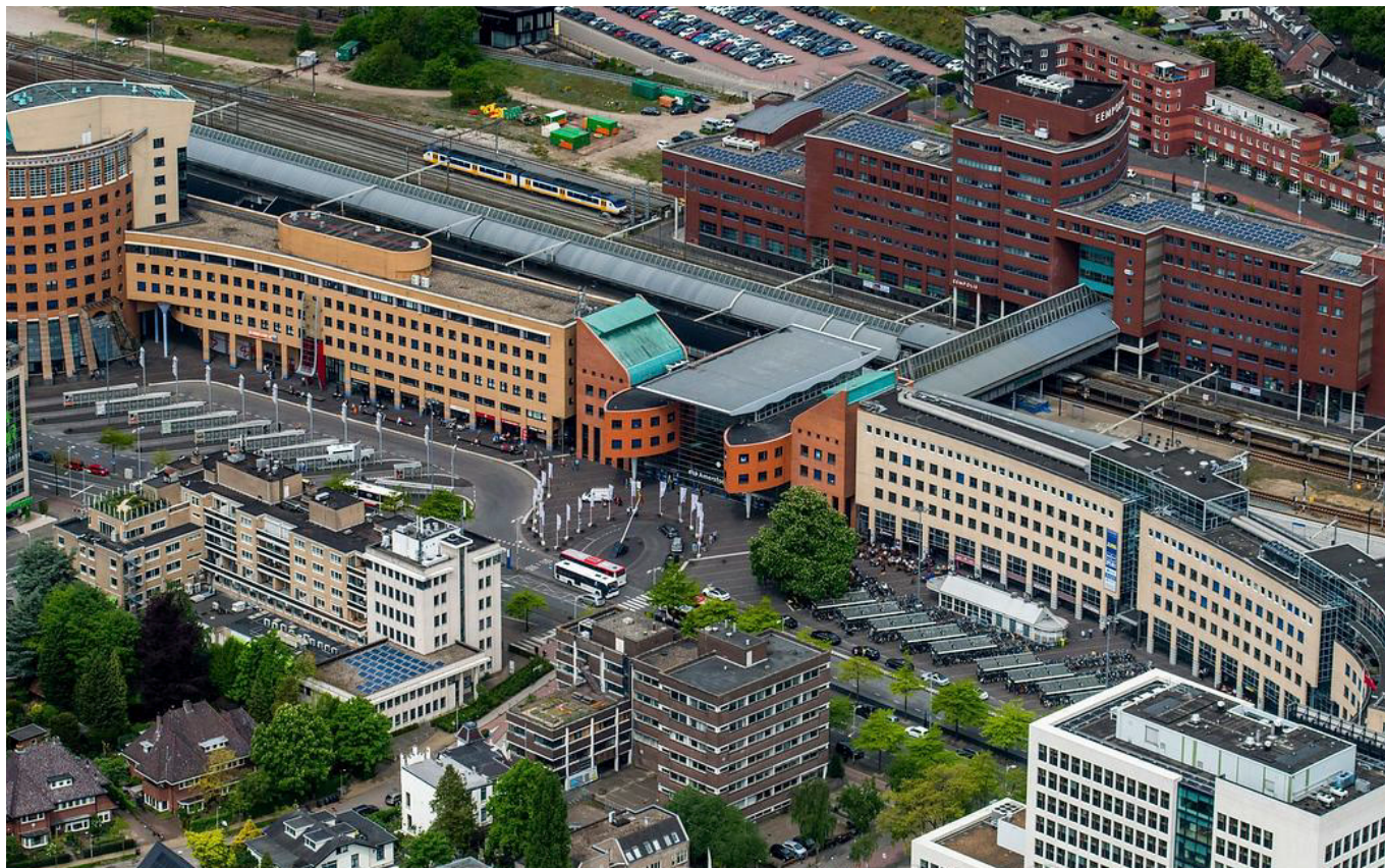
De twee percelen van Stationsplein 14 en 16 liggen op de scheiding van het lommerrijke Bergkwartier en het grootstedelijke Stationsplein.
