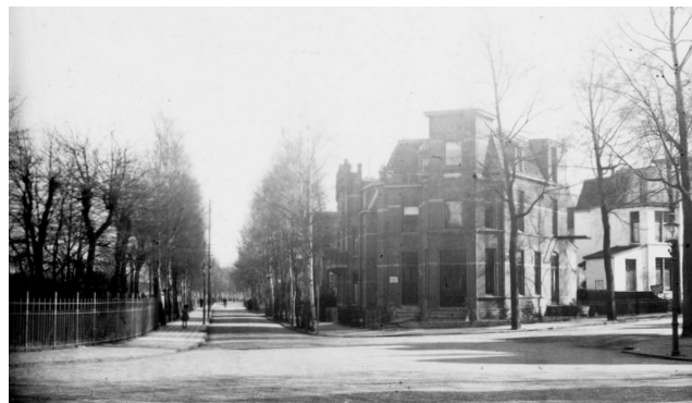
Zicht vanaf het Stationsplein naar de Berkenweg en de Regentesselaan, het witte huis rechts is het huidige Toon Hermanshuis.
