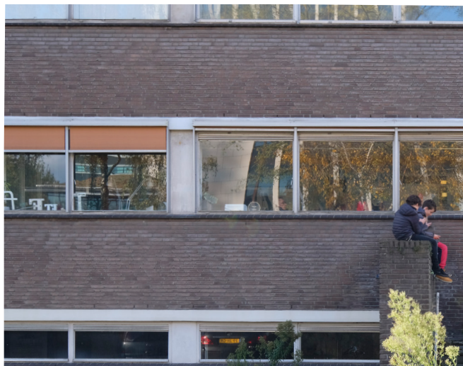
Nr. 14 - stalen kozijnen met enkel glas, externe zonwering (later aangebracht) en ventilatie roosters. Er zijn geen zichtbare scheuren in beton of metselwerk.
