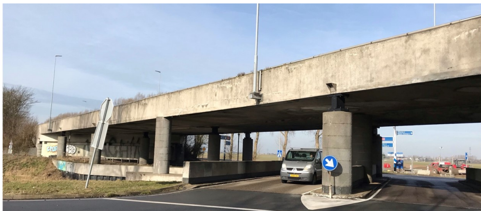
Foto 2 Viaduct Hoofdvaart Lage en Hoge Brug
