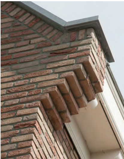
voorbeeld detail aansluiting dakgoot-kopgevel
