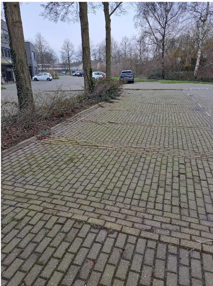
Wortelopdruk in parkeervakken door oppervlakkige beworteling
