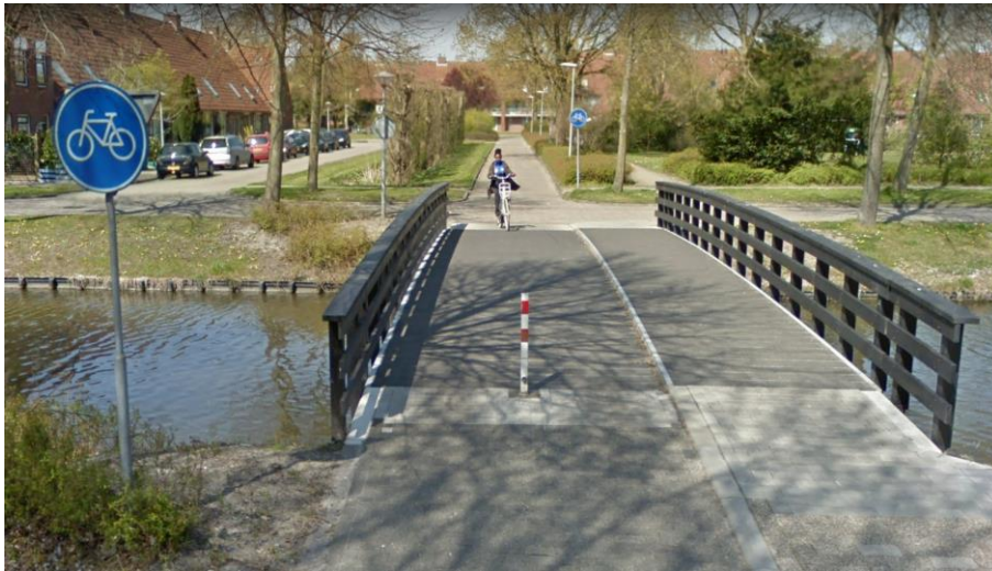
Figuur VIII.1: Fietspalen binnen Hoorn (bron: Cyclomedia)
