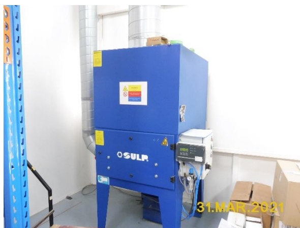
Afzuiging afdeling meel ompakken.
