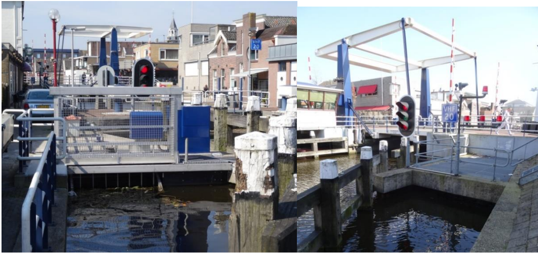
Afbeelding 1.2. Spuikoker aan de zuidzijde van de sluiskolk (links: instroomopening stroomopwaarts; rechts: uitstroomopening stroomafwaarts)
