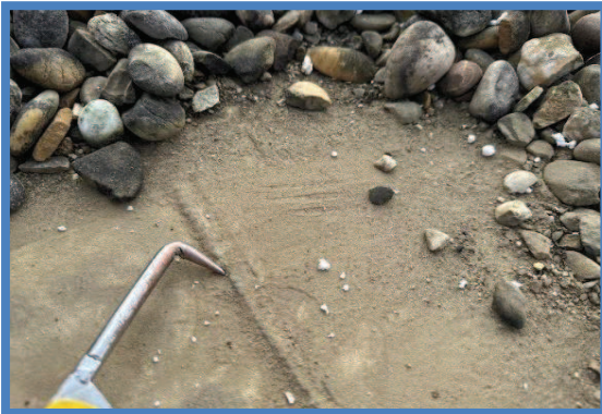
Controle dakbedekking (steekproefsgewijs)
