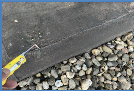
Controle dakbedekking (steekproefsgewijs)
