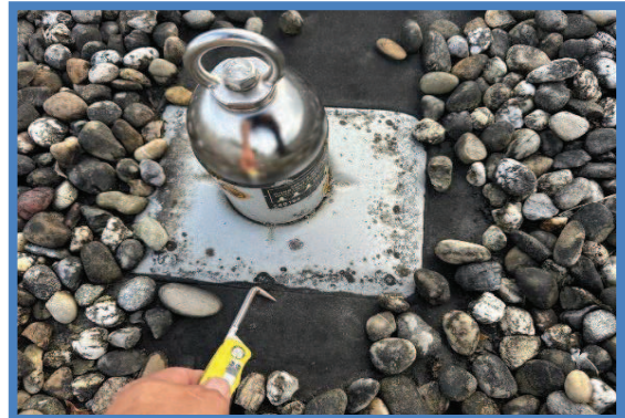
Controle dakbedekking (steekproefsgewijs)
