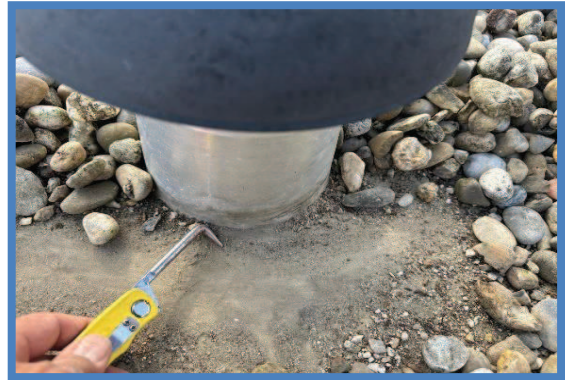
Controle dakbedekking (steekproefsgewijs)
