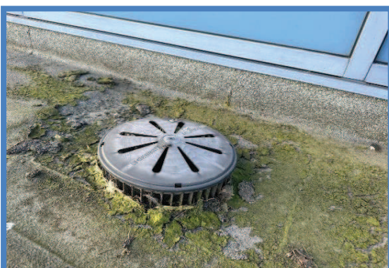
Hemelwaterafvoeren vervuild
