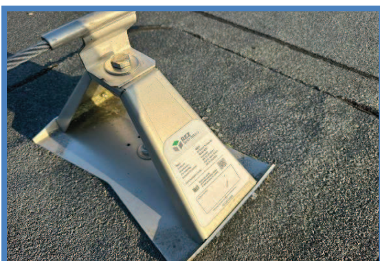
Valbeveiligingssysteem niet gekeurd
