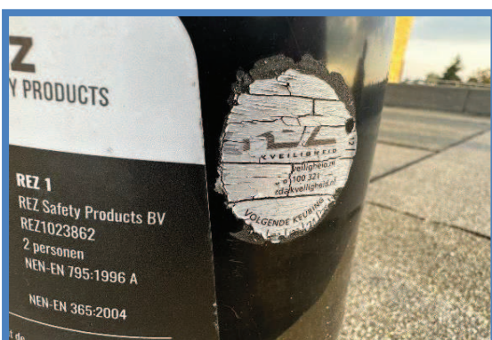
Valbeveiliging niet gekeurd
