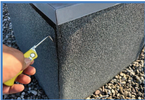
Controle dakbedekking (steekproefsgewijs)
