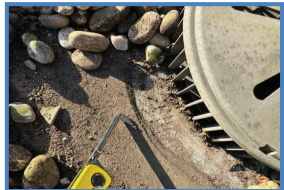
Controle dakbedekking (steekproefsgewijs)
