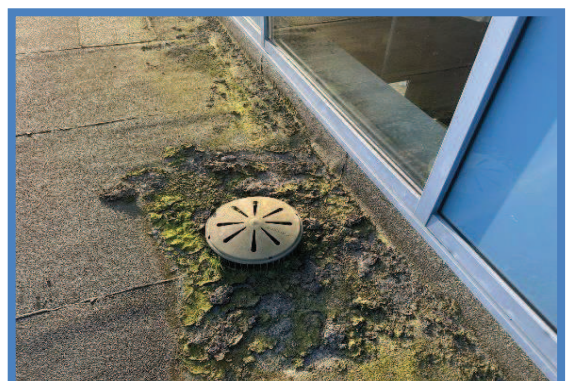
Hemelwaterafvoeren vervuild
