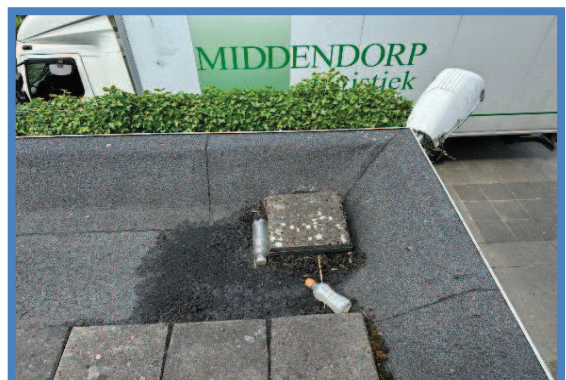
Hemelwaterafvoeren vervuild
