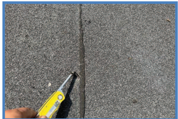
Controle dakbedekking (steekproefsgewijs)
