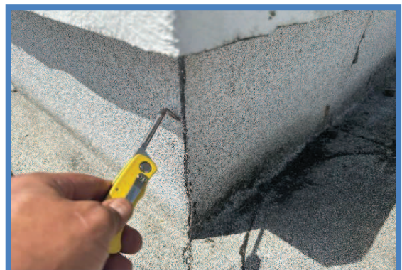
Controle dakbedekking (steekproefgewijs)
