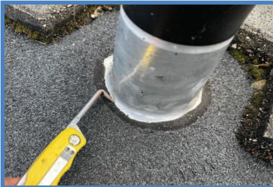
Controle dakbedekking (steekproefsgewijs)
