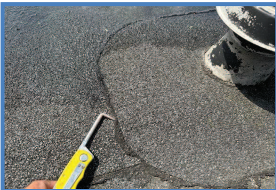
Controle dakbedekking (steekproefsgewijs)
