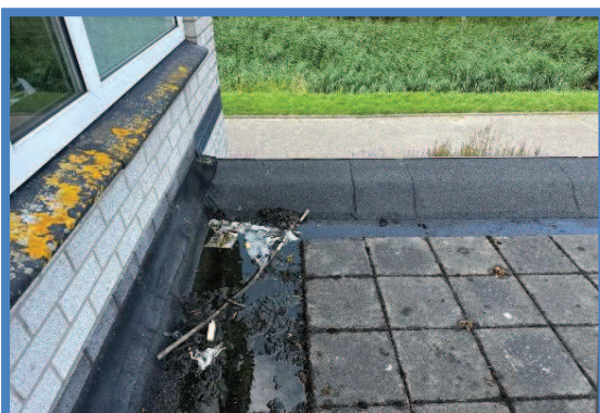
Hemelwaterafvoeren vervuild
