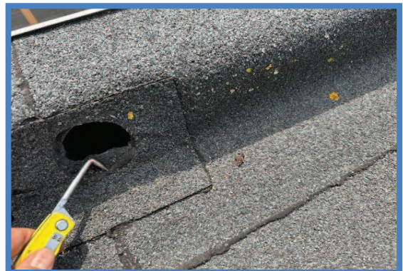
Controle dakbedekking (steekproefsgewijs)
