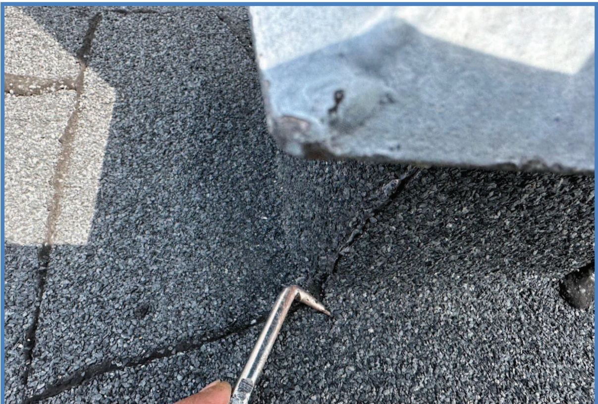
Controle dakbedekking (steekproefsgewijs)
