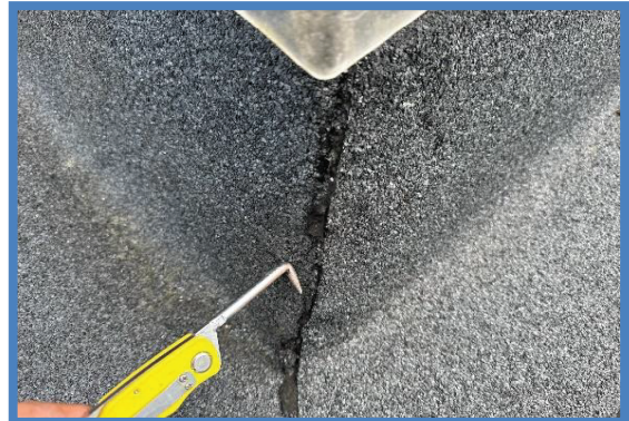
Controle dakbedekking (steekproefsgewijs)
