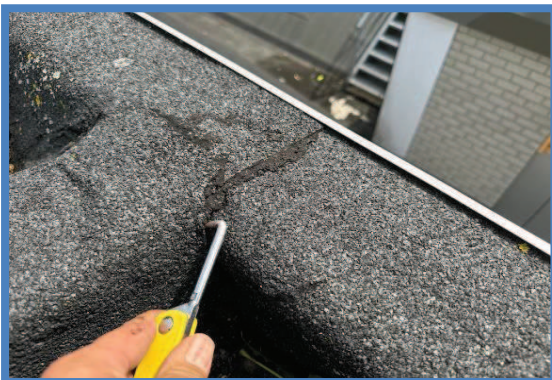
Controle dakbedekking (steekproefsgewijs)
