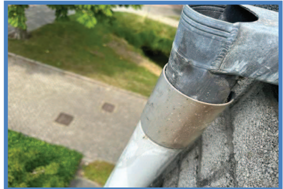
Regenpijp terug geplaatst
