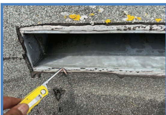
Controle dakbedekking (steekproefsgewijs)
