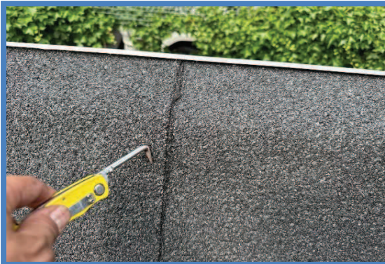
Controle dakbedekking (steekproefsgewijs)
