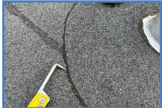
Controle dakbedekking (steekproefsgewijs)
