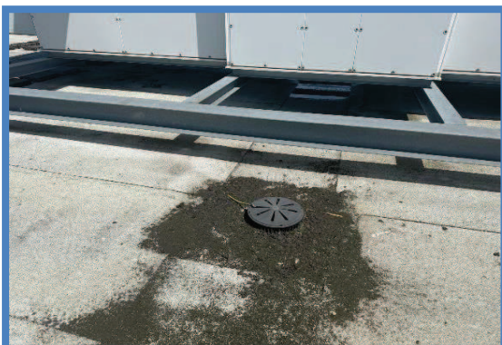
Hemelwaterafvoeren vervuild
