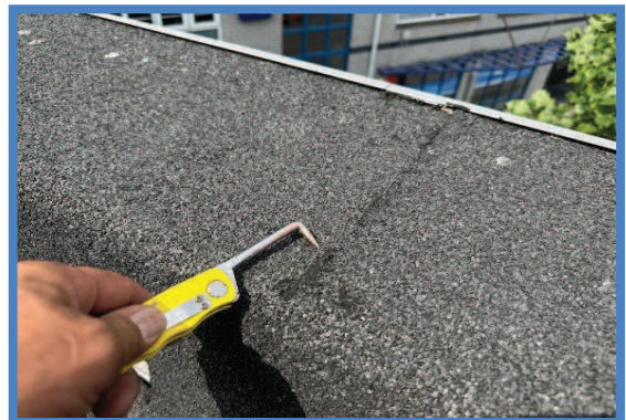
Controle dakbedekking (steekproefsgewijs)
