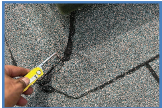
Controle dakbedekking (steekproefsgewijs)
