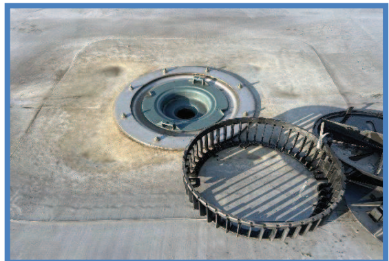
Hemelwaterafvoeren gereinigd
