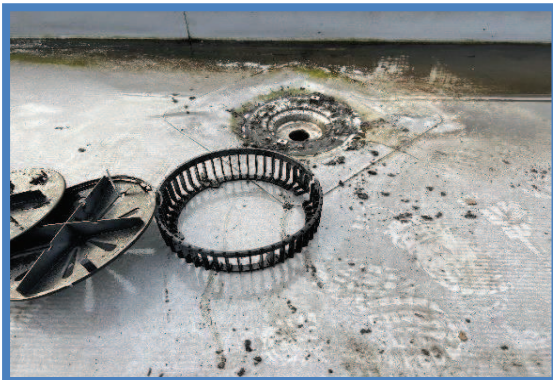
Hemelwaterafvoeren vervuild
