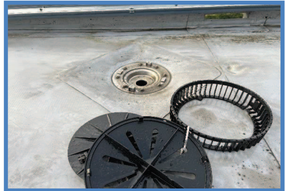
Hemelwaterafvoeren gereinigd
