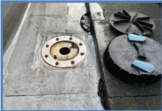
Hemelwaterafvoeren vervuild
