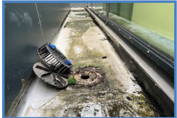
Hemelwaterafvoeren gereinigd
