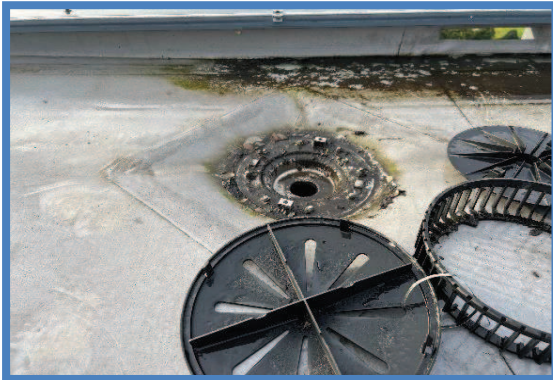
Hemelwaterafvoeren vervuild
