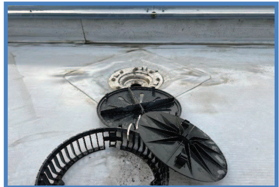
Hemelwaterafvoeren gereinigd
