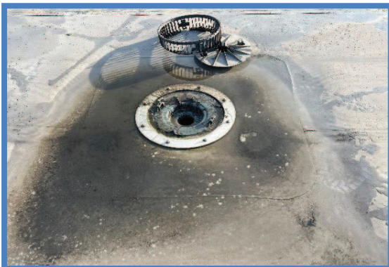
Hemelwaterafvoeren vervuild
