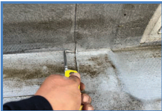
Controle dakbedekking (steekproefsgewijs)
