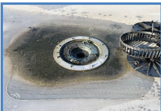
Hemelwaterafvoeren vervuild
