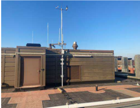
Figuur 2 Antenne langs zuidgevel
