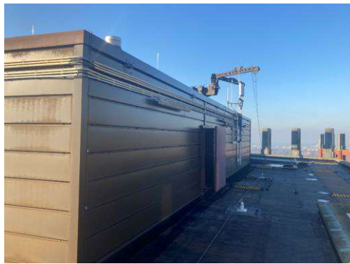
Figuur 3 Antenne langs oostgevel
