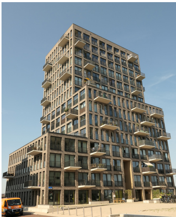
geleding in de hoogte, robuust metselwerk
