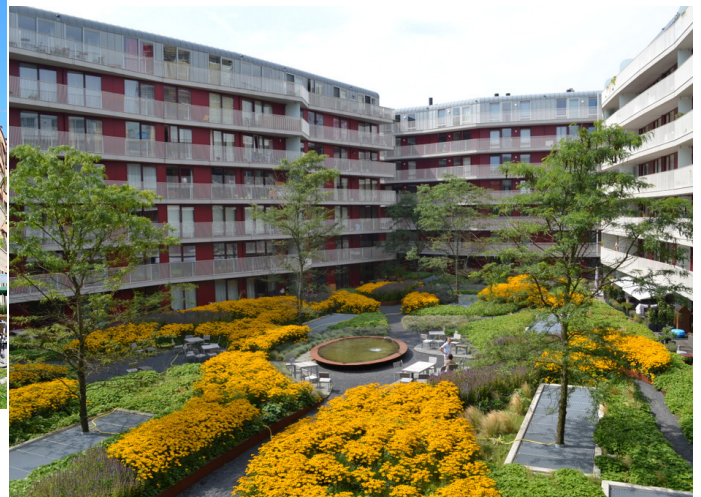
groen binnenterrein op dek, bomen staan in garage
