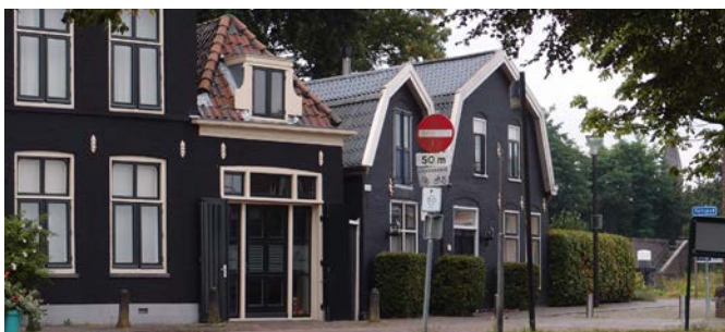
afgeschuinde gevels in het lint
