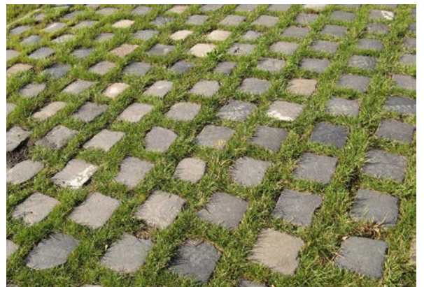
Verharding parkeerplaatsen, natuursteen met gras
