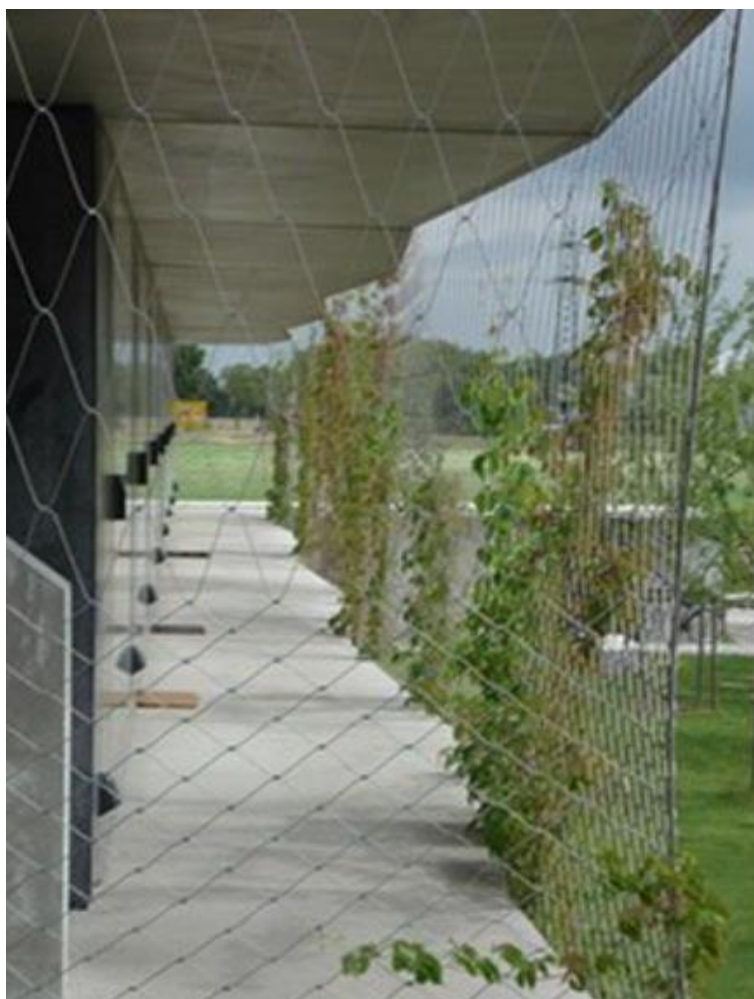
Voorbeelden randkabels bevestiging gaashekwerk
