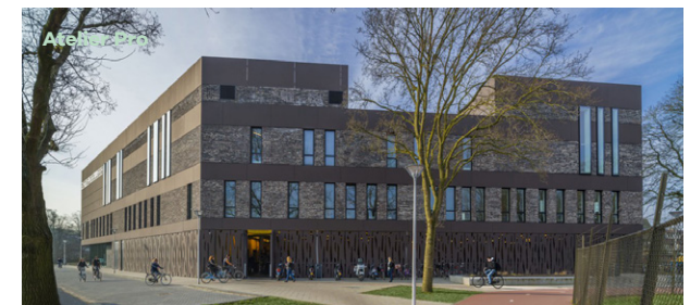
Installaties onderdeel architectuur
