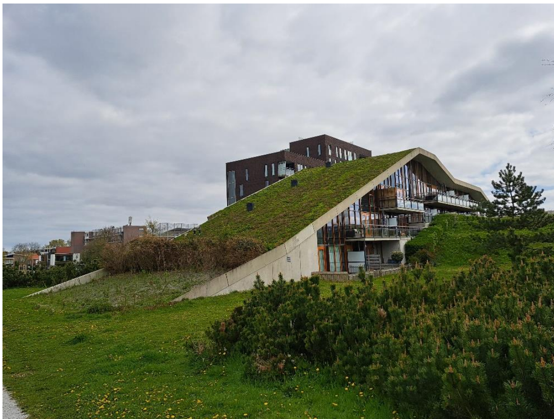
Bebouwing met groen dak aan noordzijde projectgebied
