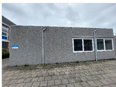
Figuur 2.7 Het ten noordoosten gelegen noodgebouw.
