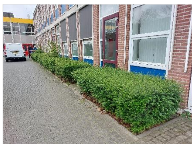
Figuur 5.4 Een van de gevels met zonwering.
