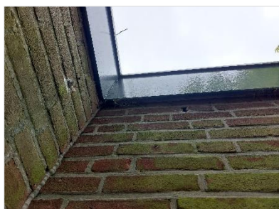
Figuur 5.3 Een van de gevels met open stootvoegen.
