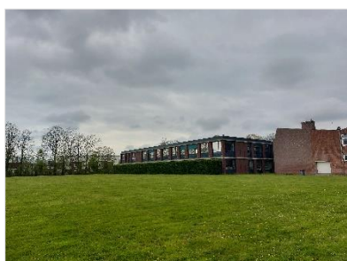
Figuur 2.6 Het ten zuiden gelegen sportveld met de nieuwbouw, welke ten westen van het hoofgebouw is gelegen.
