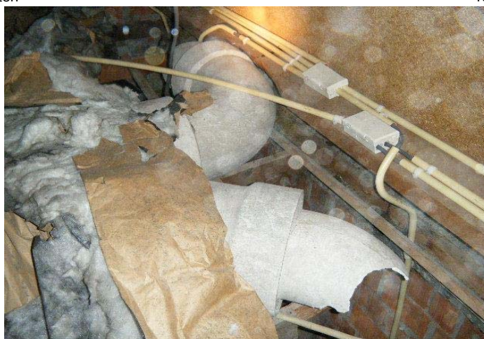
vliering, met kapot geslagen ontluuchtingspijpen
