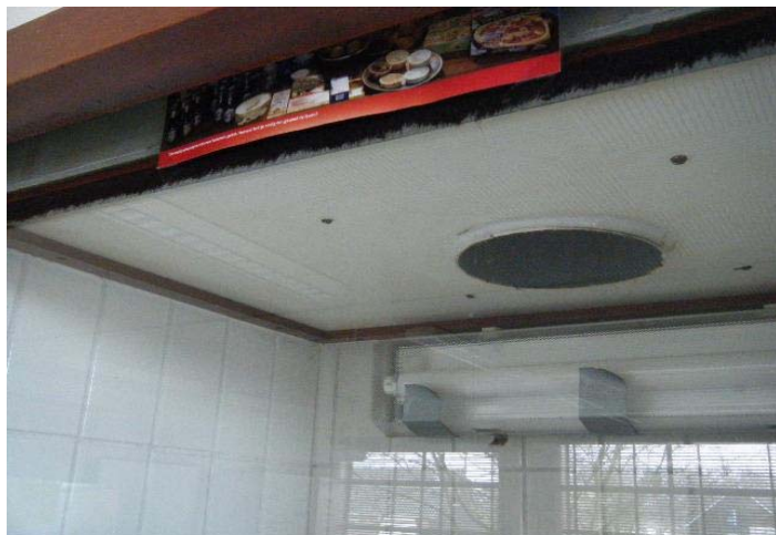
plafondplaat in zuurkast
