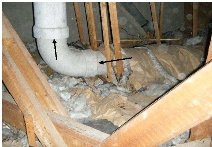
ontluchtingspijp in vliering
