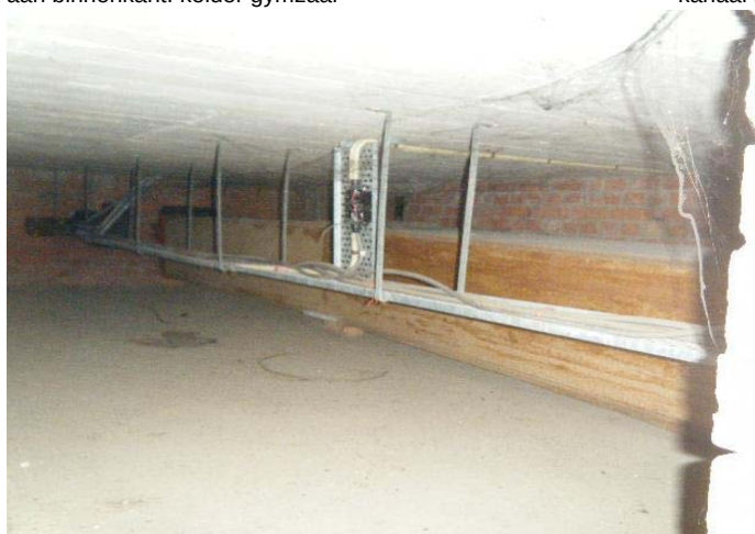
kanaal in kruipruimte
