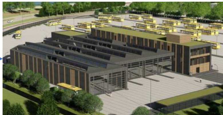
Aansluiting kantoor + installaties
