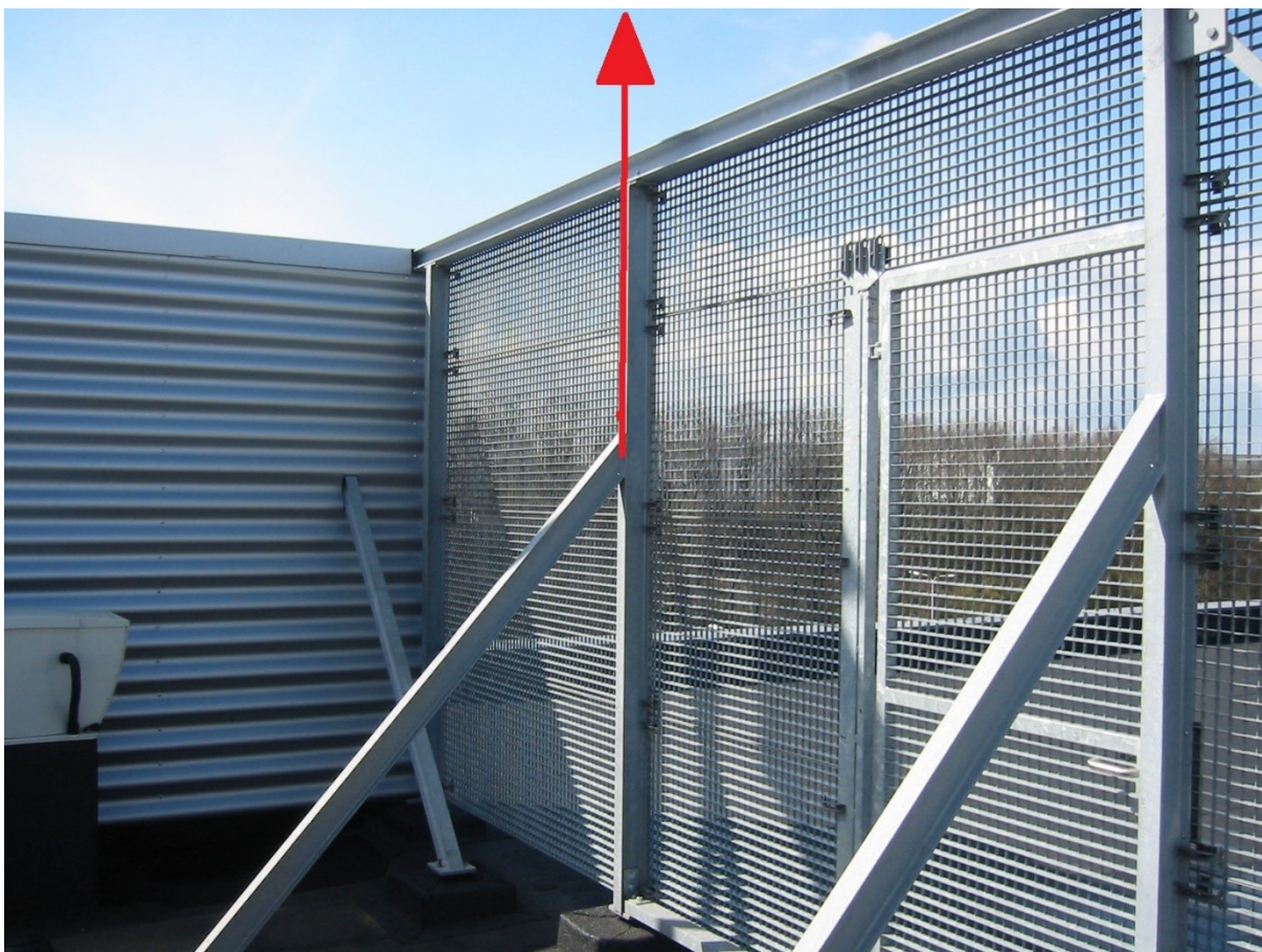
Antenne is bevestigd aan een stalen constructie op het platte dak. De antenne is met een ladder te vanaf het platte dak te bereiken.
