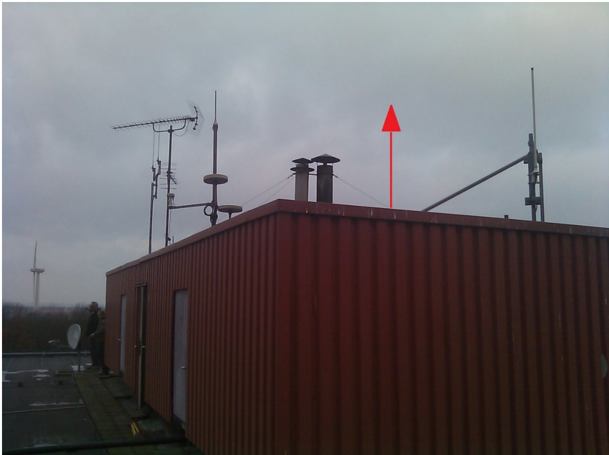
Dakvlak / antenne is met vaste muurladder te bereiken.
