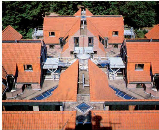
Loopbruggen over het dak vormden de verbinding tussen de verschillende vleugels
