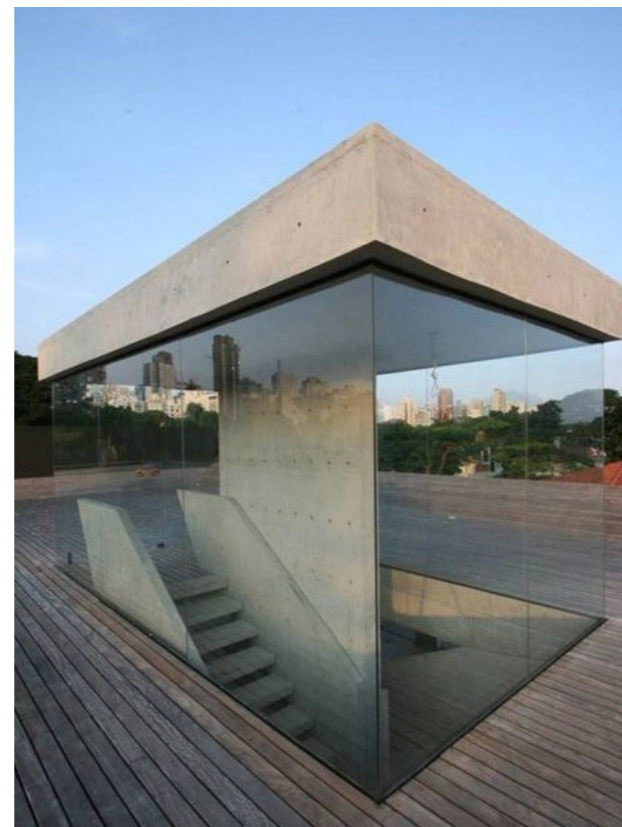
Ingang tot de fietsenkelder
