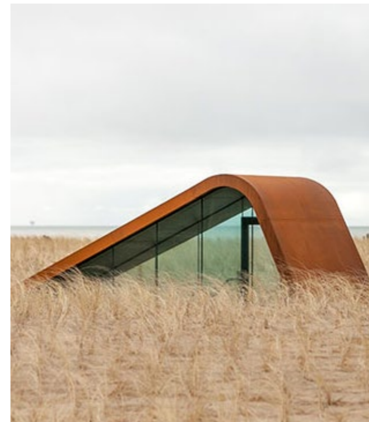
Ingang tot de fietsenkelder
