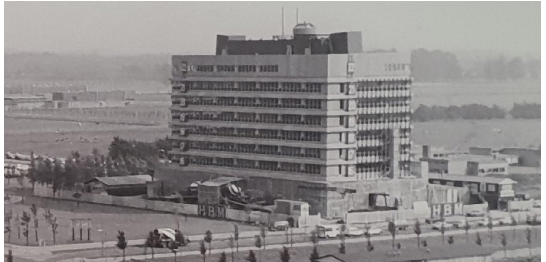
Het gebouw wordt opgevoerd volgens het Jack-Blockstelsel
