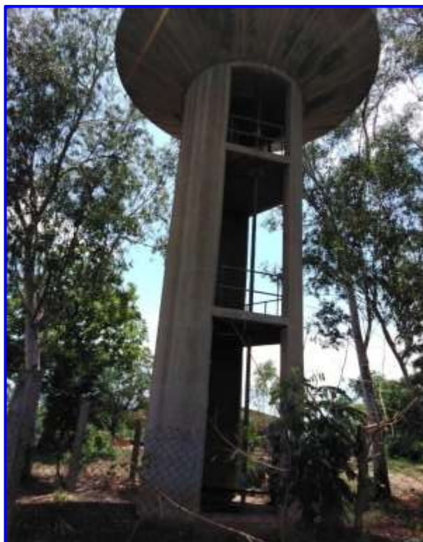
Photo 4 : Vue du château d'eau 6
