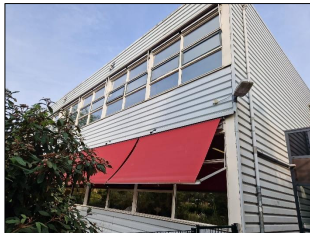
Fig. 2.5, Zuidoostzijde van te renoveren projectgebouw (bron: FF Solutions)
