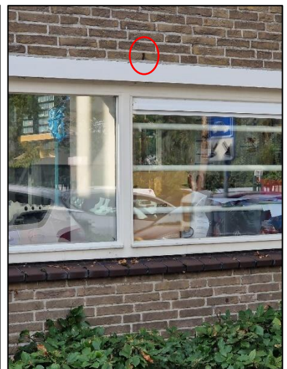
Fig. 2.12, Detailopname open stootvoeg (rood omrand) (bron: FF Solutions)
