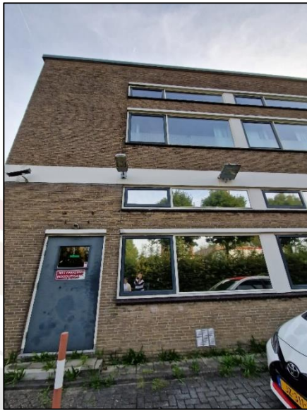
Fig. 2.8, Bakstenen gedeelte van te renoveren pand (bron: FF Solutions)
