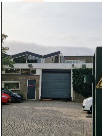
Fig. 2.10, Vooraanzicht te amoveren pand met dakopbouw (bron: FF Solutions)
