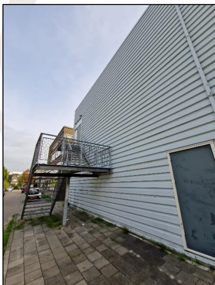
Fig. 2.6, Zuidwestgedeelte van te renoveren projectgebouw (bron: FF Solutions)
