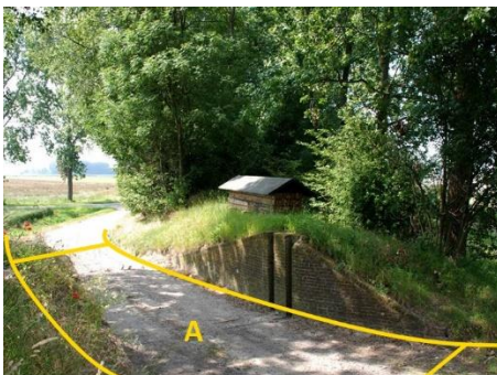
Coupure Wijk bij Duurstede (schuifdeur en 2 sponningen)
