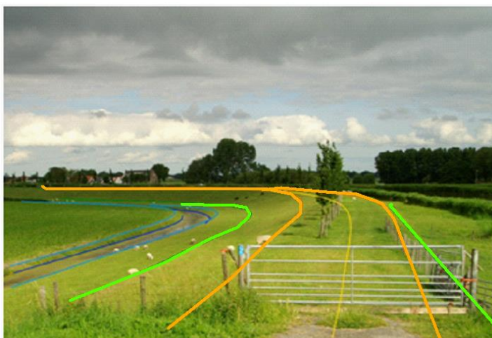
Figuur 10-5: Kenmerkende profiellijnen geprojecteerd over de kering (kruinlijn = oranje, teenlijn = groen)
