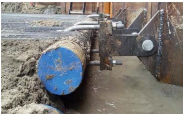
Figuur 4-4: Dubbelgeslagen geogrid om stalen buis aan damwand en geogrid met klemverbinding
