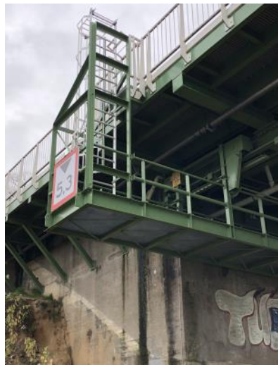
Foto toegang naar inspectiewagen bij de brug over het Julianakanaal bij Berg
