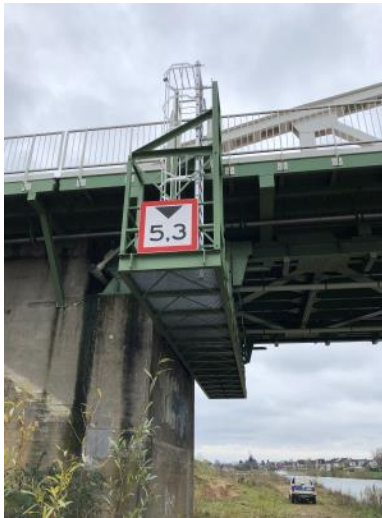
Foto toegang naar inspectiewagen bij de brug over het Julianakanaal bij Berg
