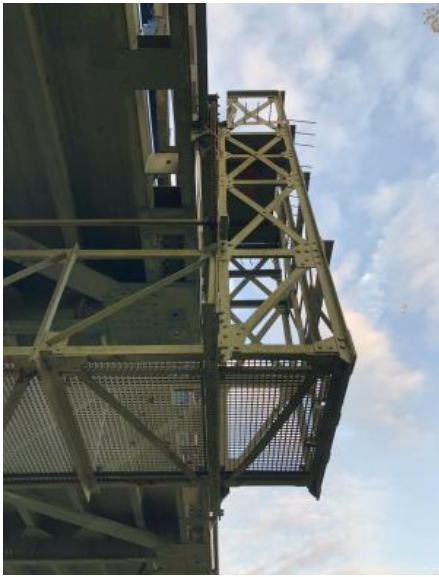
Foto's rondom luik naar toegang inspectiewagen bij brug Obbicht
