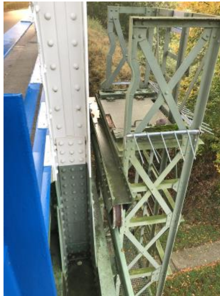
Foto's rondom luik naar toegang inspectiewagen bij brug Obbicht
