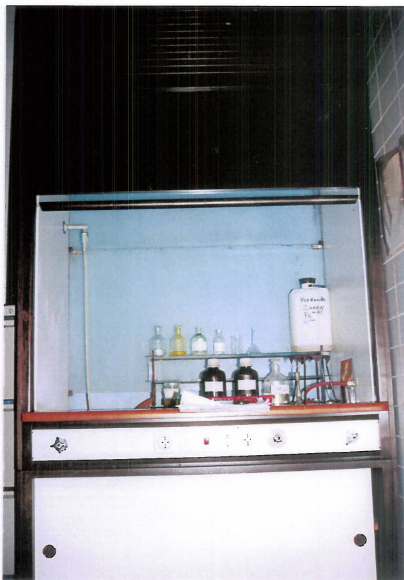
FOTO 10 (nr. 13): Asbesthoudend plaatmateriaal in de zuurkast in gebouw 4
