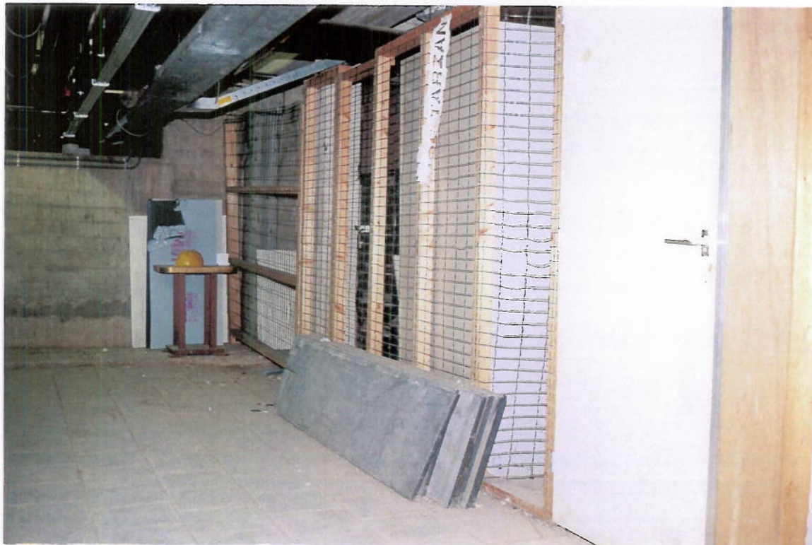
FOTO 9 (nr. 12): asbesthoudend plaatmateriaal in de kelder van gebouw 4
