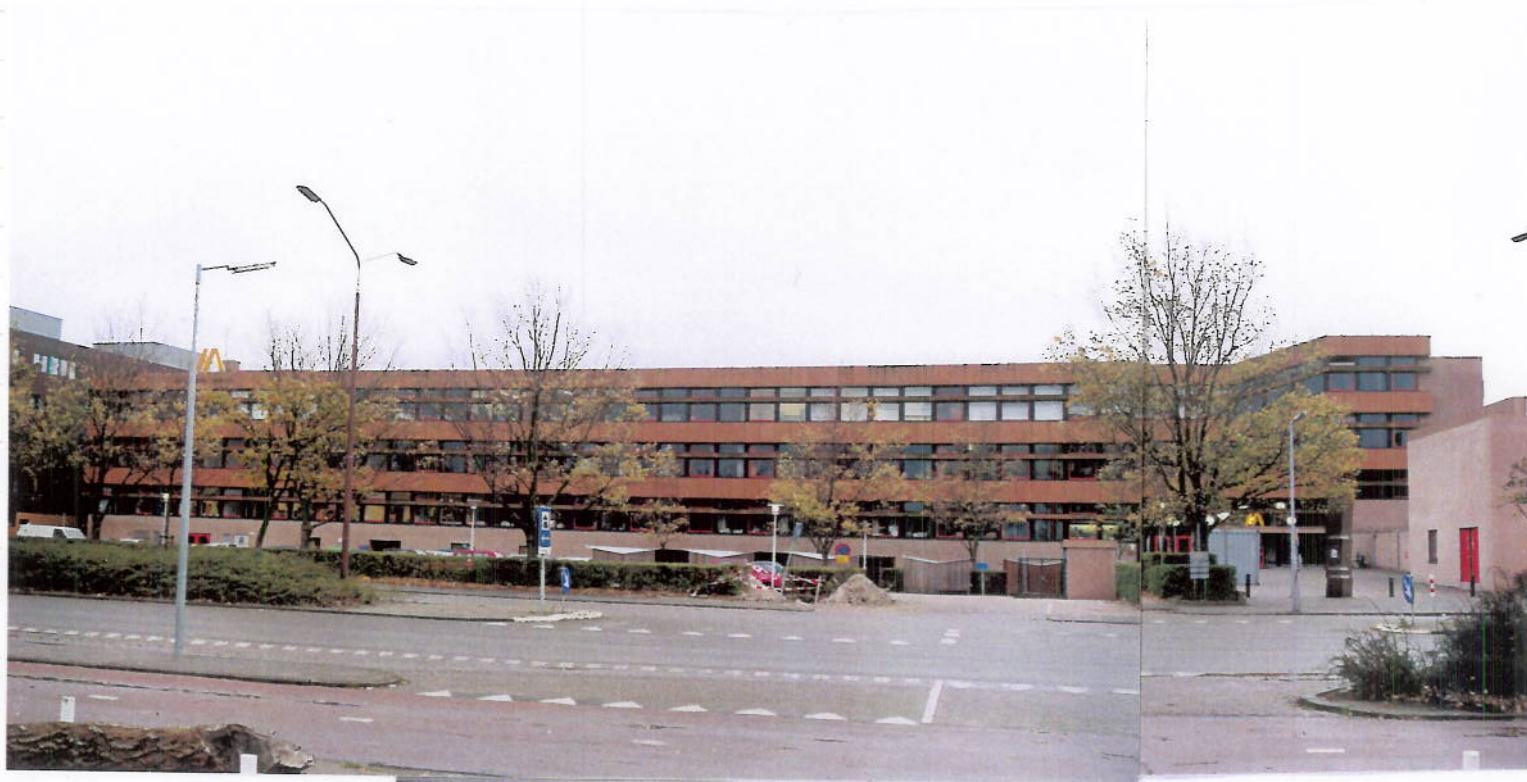
hoofdgebouw school (hoogbouw)
