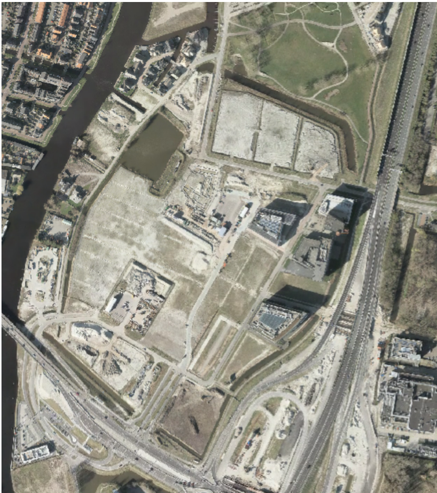
Afbeelding 2.1 Luchtfoto plangebied huidige situatie
