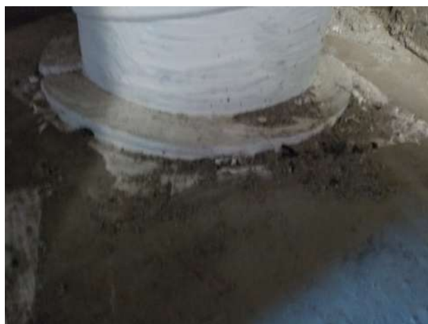
Luchtkanaal met afdichting
