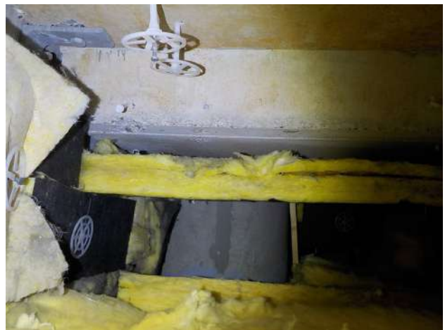
De betonconstructie bij de dakoverstek is volledig ingepakt met glaswol isolatiematten
