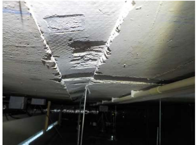
Restafdrukken in gesaneerde locatie
