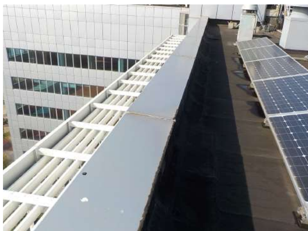
Dakrand 10e verdieping
