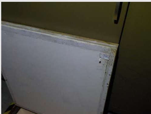
Beplating tegen vloerluik
