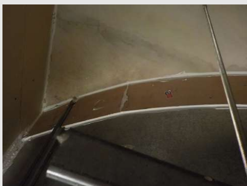
Afscherming tussen luchtkanaal en betonplafond
