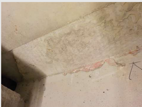
Intacte bekisting, 6e verdieping
