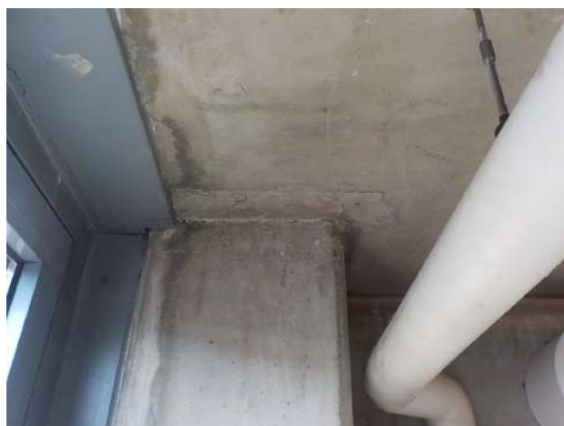
Verloren bekisting bij betonkolom, 10e verdieping
