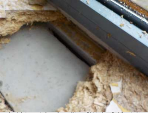
In de buitengevels (inspectie vanaf binnenzijde) is glaswolisolatie gebruikt
