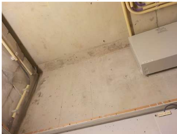
6e verdieping, betonplafond met strook bekisting
