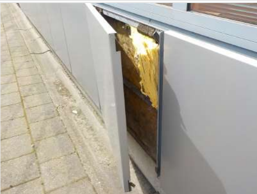
Inspectie achter stalen gevelpanelen (geen asbestbron)
