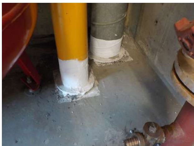
Afdichting bij vloer
