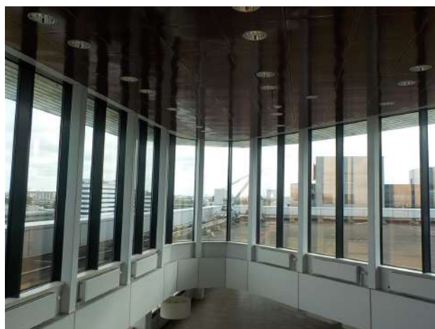
Kolommen op 9e verdieping
