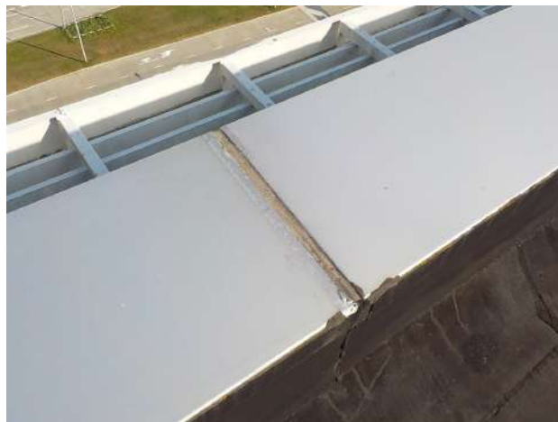
Kit tussen dakrandpanelen
