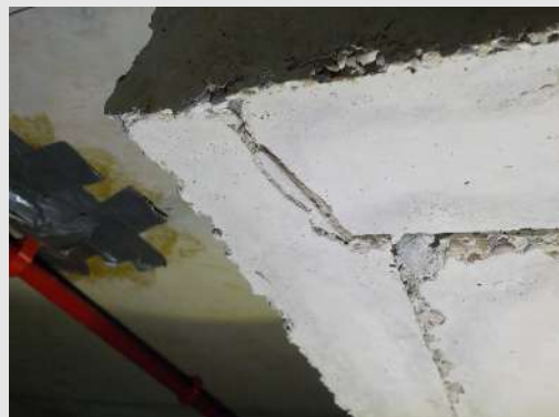
Overgeslagen stukje bekisting
