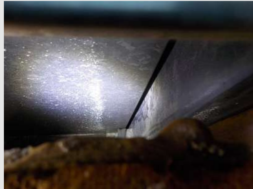
Inspectie in de glasgevels
