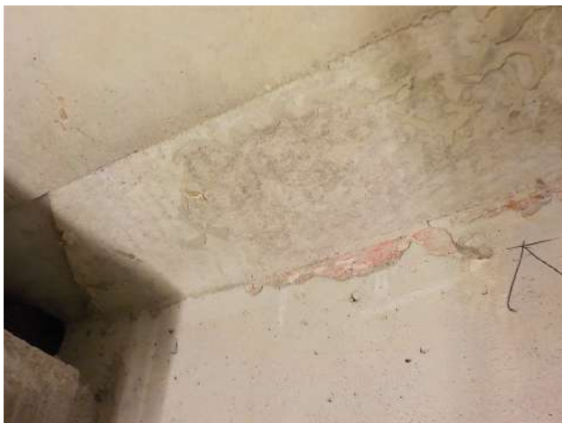
Intacte bekisting, 6e verdieping
