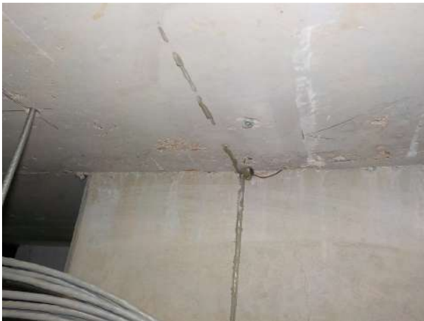
Kit op betonplafond en betonkolom
