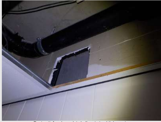
Destructief onderzoek in holle ruimten bij de pantry
