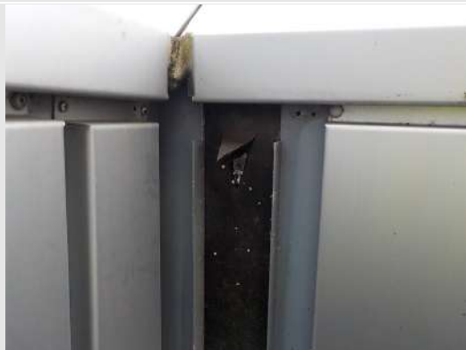
Inspectie achter de stalen panelen en dakbedekking van de dakrandopstanden: geen asbestbronnen
