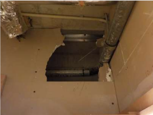
Destructief onderzoek in holle ruimten pantrys
