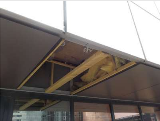
Inspectie in dakoverstek
