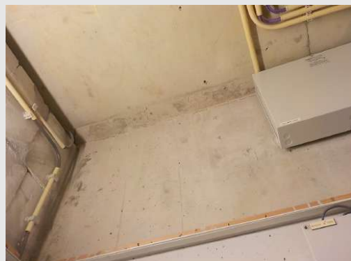
6e verdieping, betonplafond met strook bekisting
