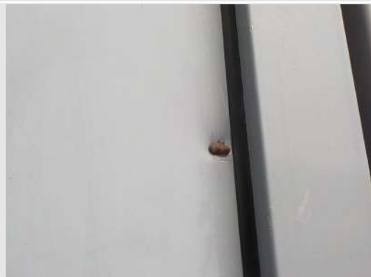
Stalen kozijnpaneel: glaswolisolatie
