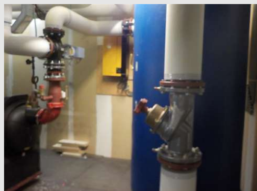
Nieuwe installaties op de 9e verdieping
