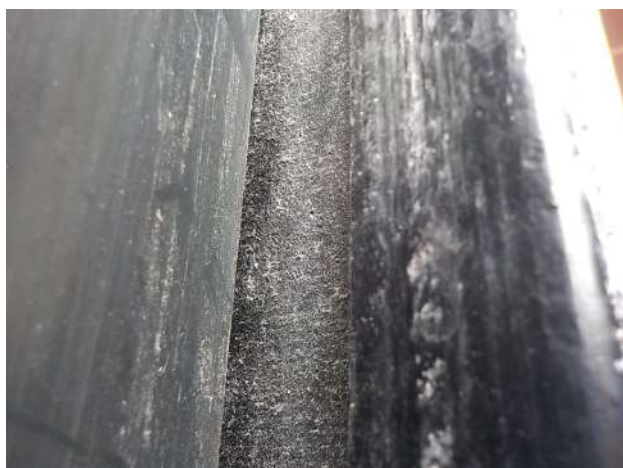
Brandwerende beplating aan achterzijde kolommen
