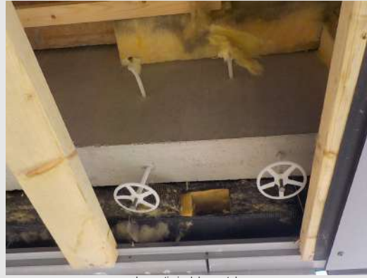
Inspectie in dakoverstek
