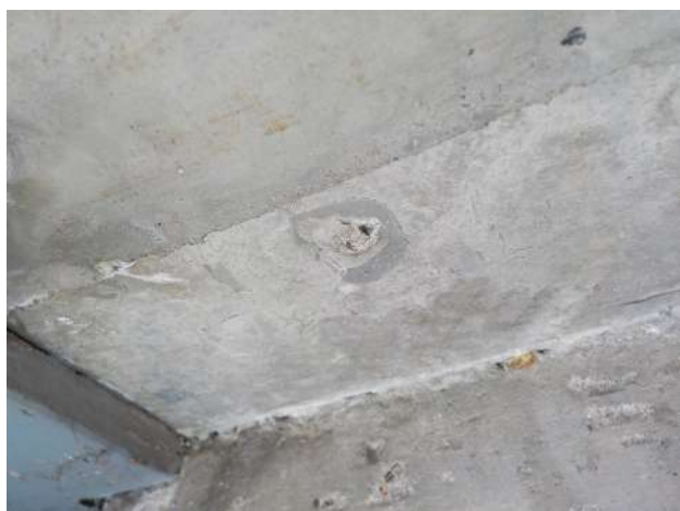
Intacte bekisting op 10e verdieping
