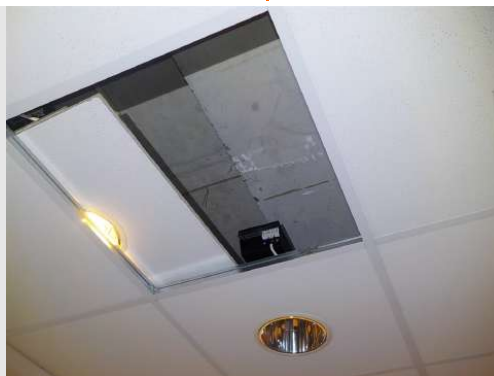
De kit is aanwezig boven het verlaagd plafond
