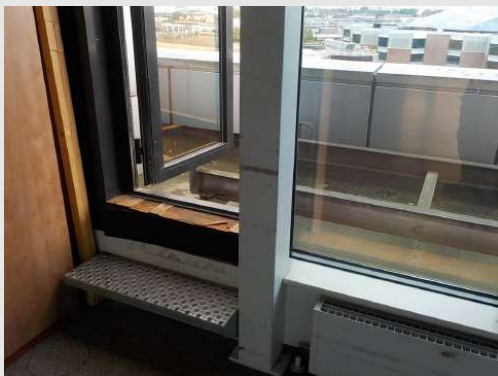
De kolom is afgetimmerd met hout
