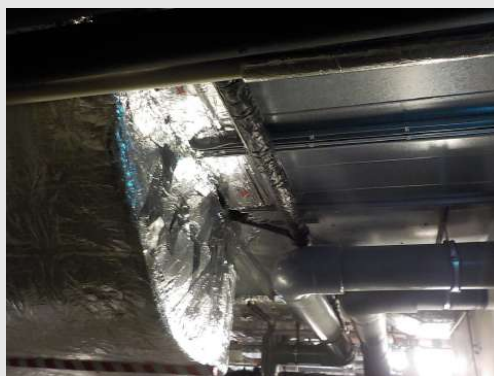
Afscherming tussen luchtkanaal en betonplafond
