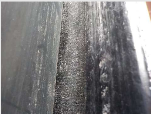
Brandwerende beplating aan achterzijde kolommen
