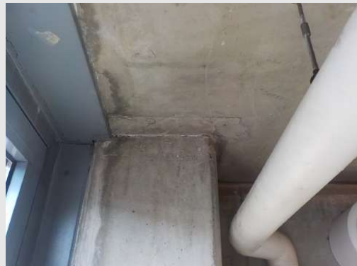
Verloren bekisting bij betonkolom, 10e verdieping
