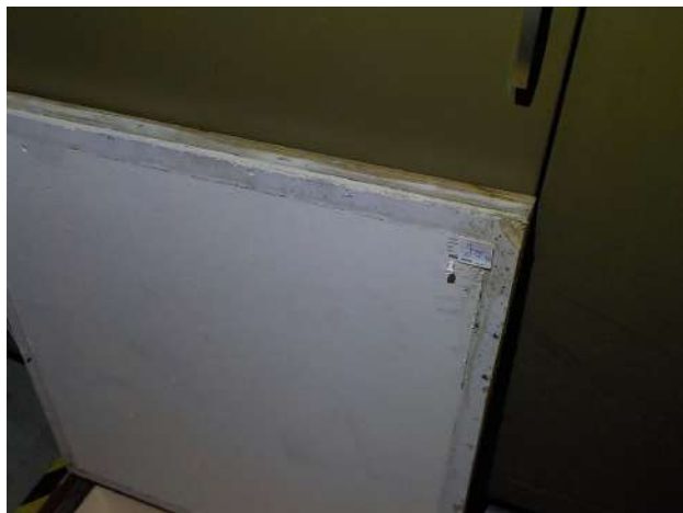
Beplating tegen vloerluik
