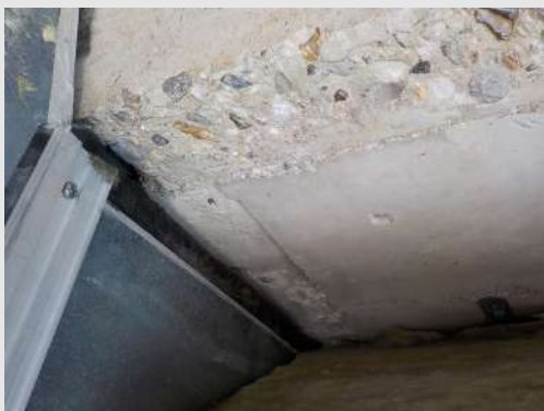
Slecht uitgehakte bekisting in de paddestoelen dakoverstek
