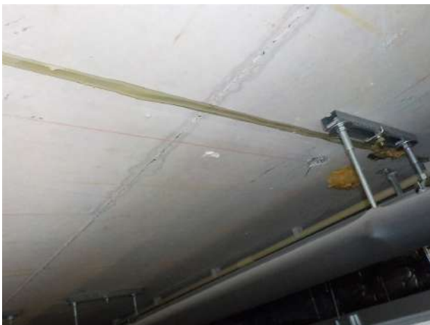
Kit op betonplafond en betonkolom
