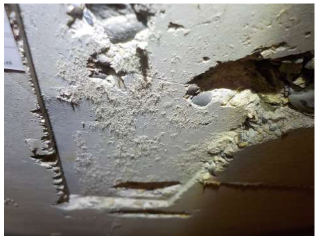
Vezelresten/afdrukken, achtergebleven na sanering en eindcontrole
