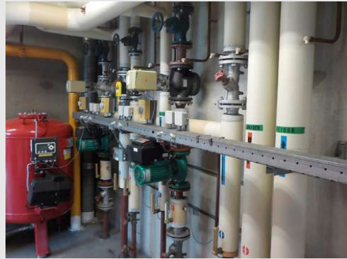
Pakkingen in cv-ruimte 10e verdieping
