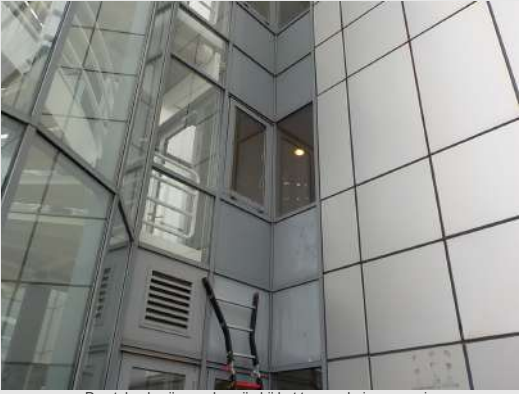
De stalen kozijnpanelen zijn bij het trappenhuis aanwezig
