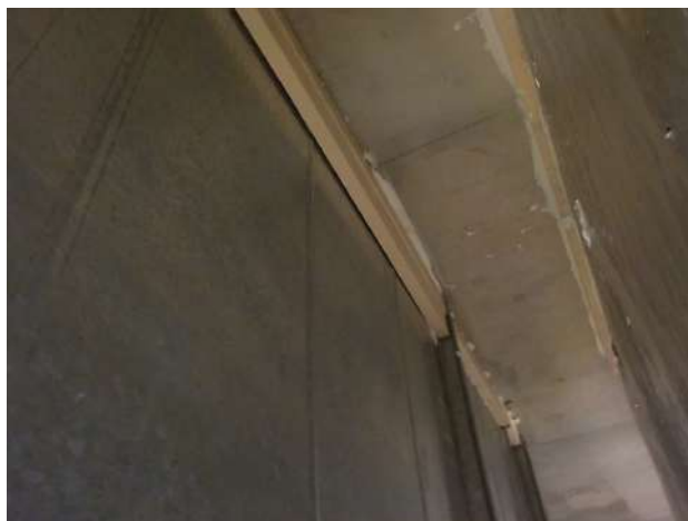
Afscherming tussen luchtkanaal en betonplafond
