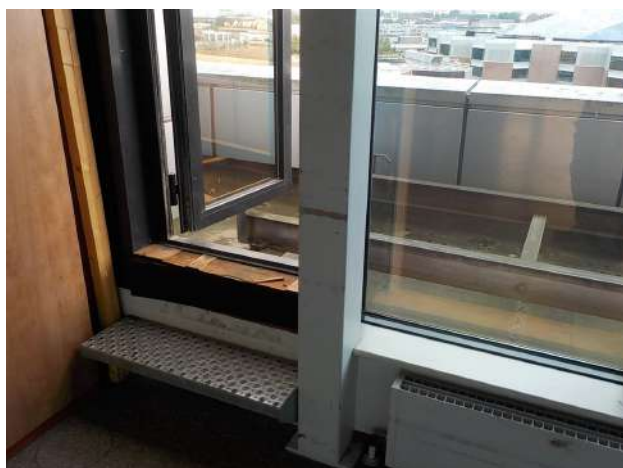
De kolom is afgetimmerd met hout
