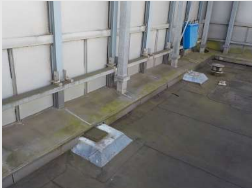
Kit staande panelen, bij staalconstructie
