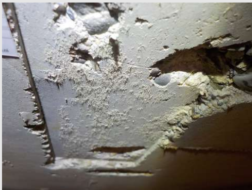
Vezelresten/afdrukken, achtergebleven na sanering en eindcontrole
