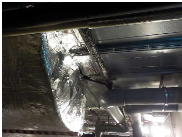
Afscherming tussen luchtkanaal en betonplafond
