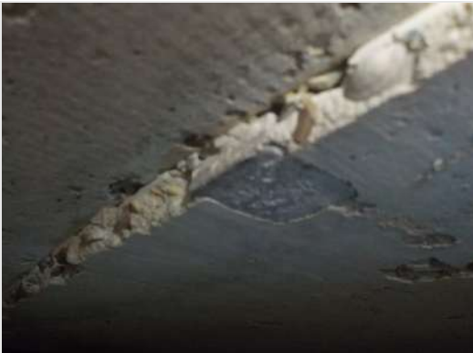
Tijdens de inspectie is geconstateerd dat de afstandhouders in het betonwerk bestaan uit beton/cementblokjes (niet asbestverdacht)
