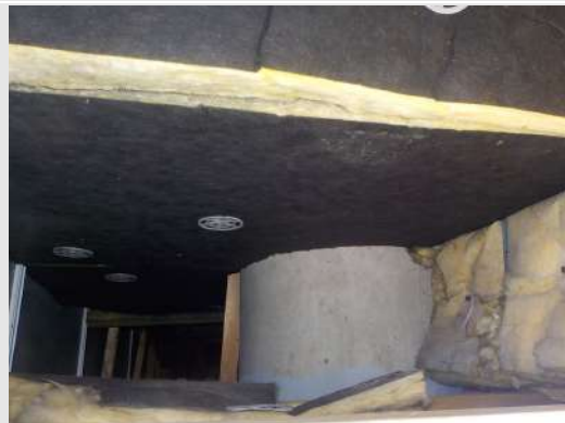
Dakoverstek: bij de kolommen is verloren bekisting van bron 9 aanwezig (bedekt door de isolatiematten)
