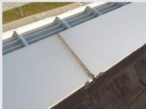
Kit tussen dakrandpanelen
