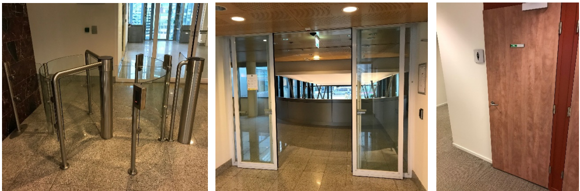
Figuur 6: a. toegangspoort, b. automatische dubbele schuifdeur en c. HPL binnendeur
