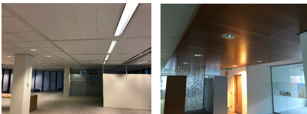
Figuur 8: a. systeemplafond en b. akoestische panelen
