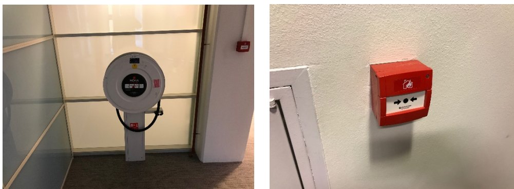
Figuur 9: a. brandslanghaspel en b. handbrandmelder
