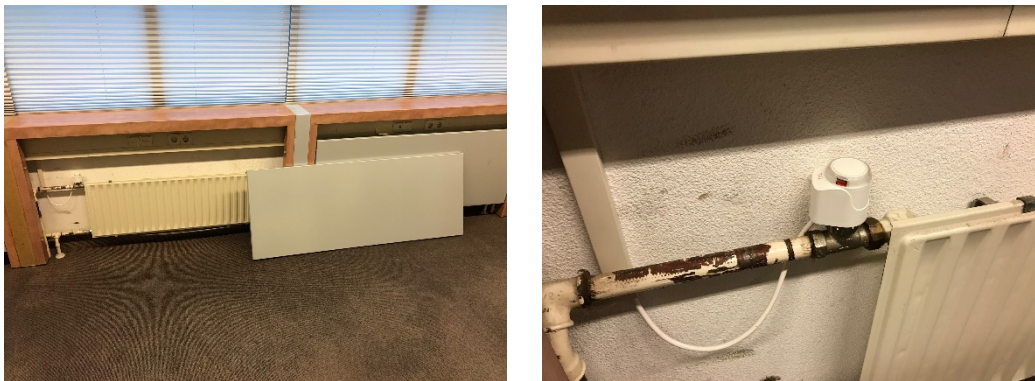
Figuur 10: a. enkele paneelradiator en b. stralingspaneel
