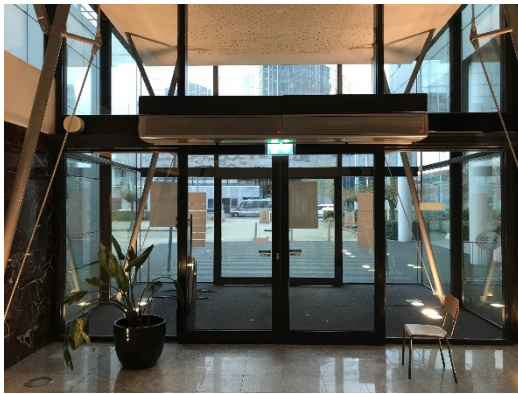
Figuur 3: dubbele automatische schuifdeuren
