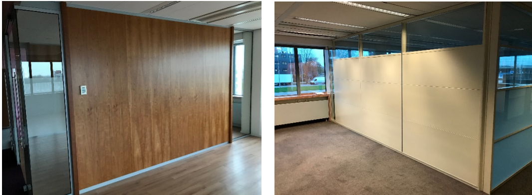
Figuur 5: panelen systeemwanden
