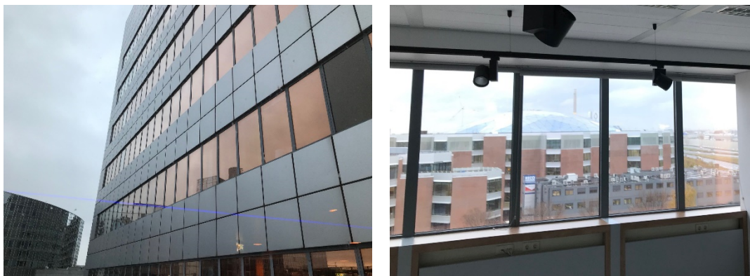
Figuur 2: a. aluminium gevelcassettes en b. aluminium kozijnen
