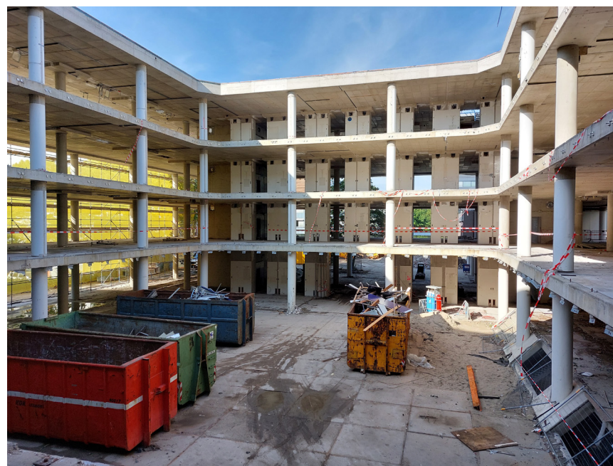
Overzicht constructie vanuit atrium
