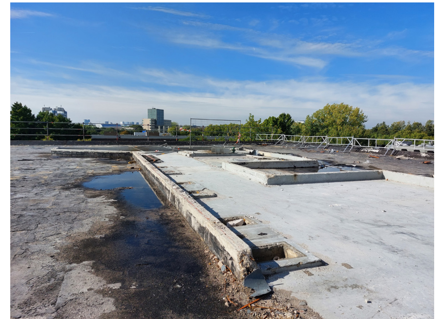
Dakvloer met afschot en opstortingen installatieruimtes
