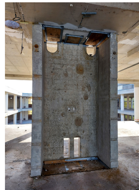
Prefab beton leidingschacht
