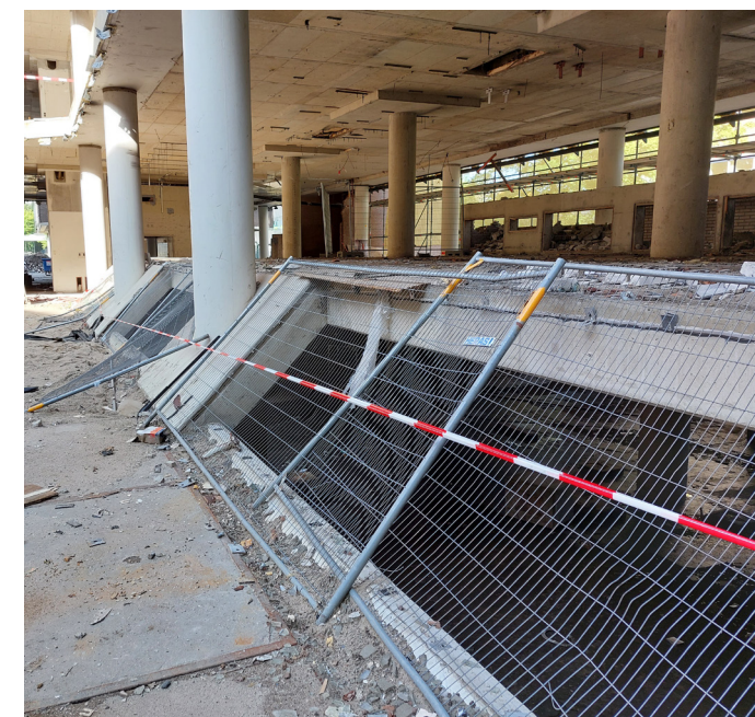
Half verdiepte kelder
