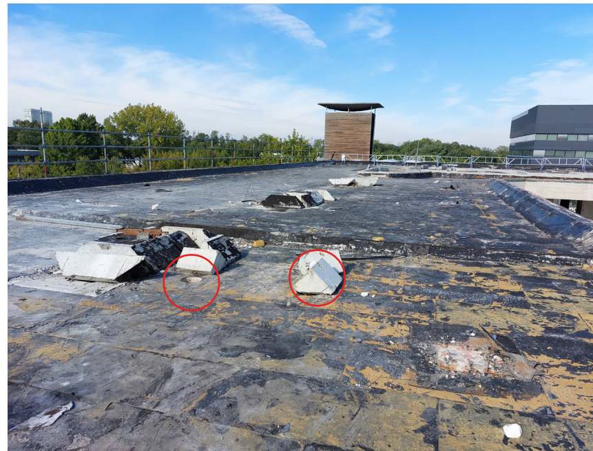
Dakvloer met restanten dakbedekking en extra sparingen
