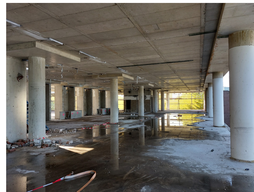
Overzicht constructie 3e verdieping
