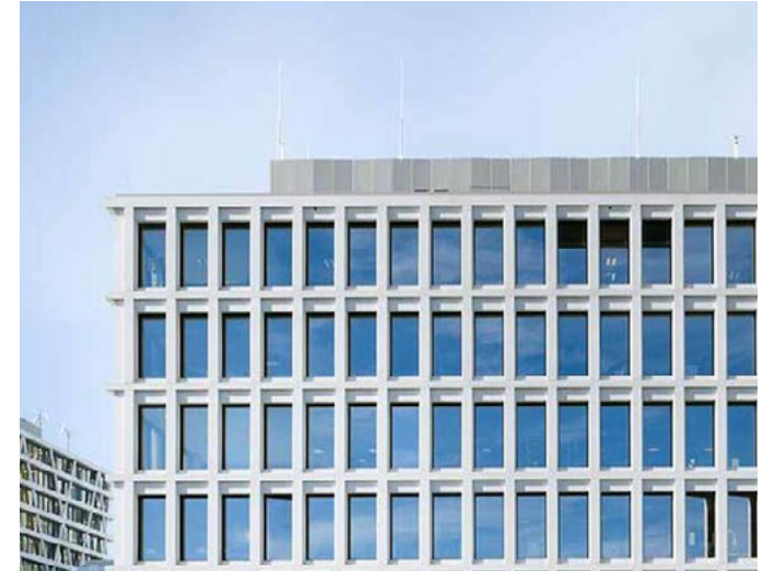
Installaties dakopbouw samenhangend en ingetoren ontworpen
