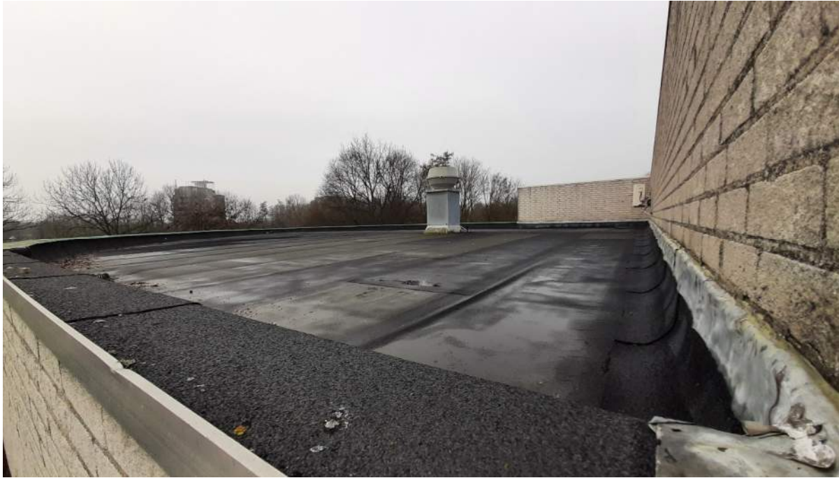
Exterieur dak Trix Terwindtstraat 4
