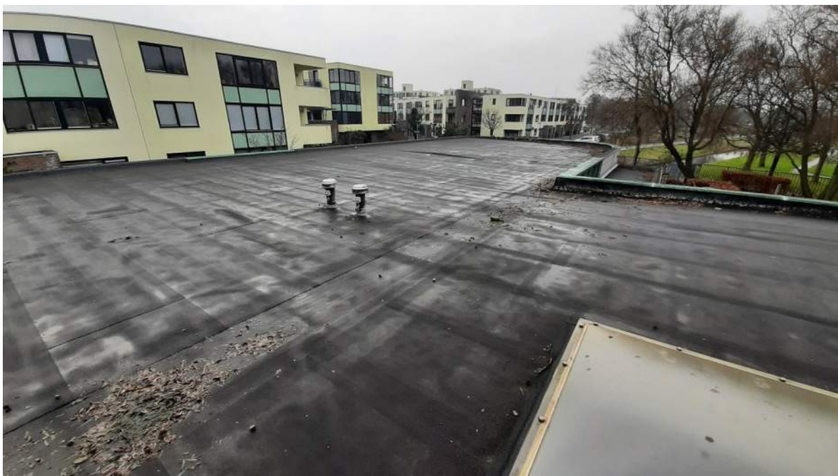
Exterieur dak Trix Terwindtstraat 2
