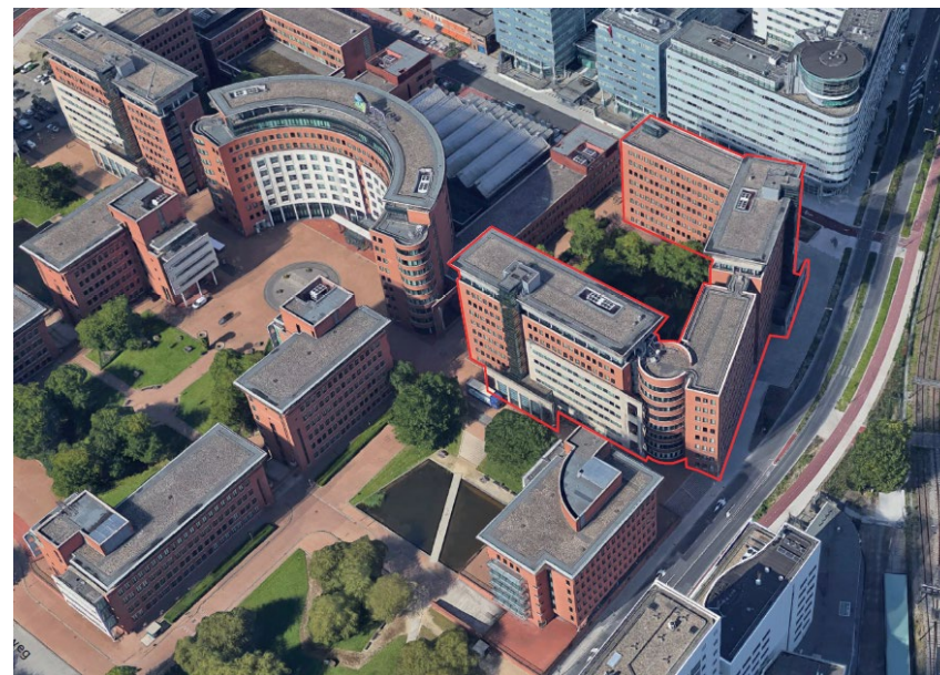
Bovenstaand, gebouw Universe op Green Campus
