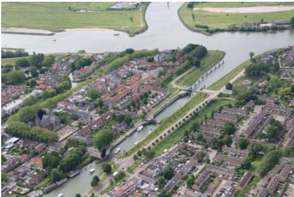
Luchtfoto: complex Koninginnensluis met op de achtergrond de Lek
