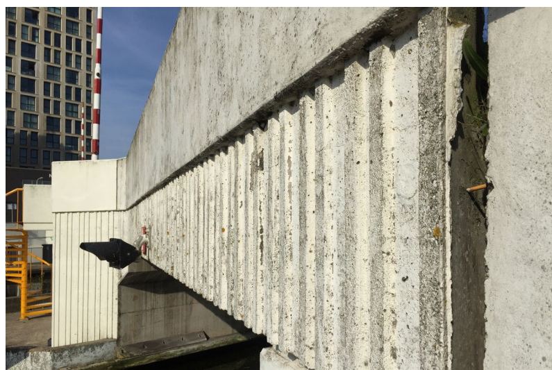
profilering van de betonnen brugrand
