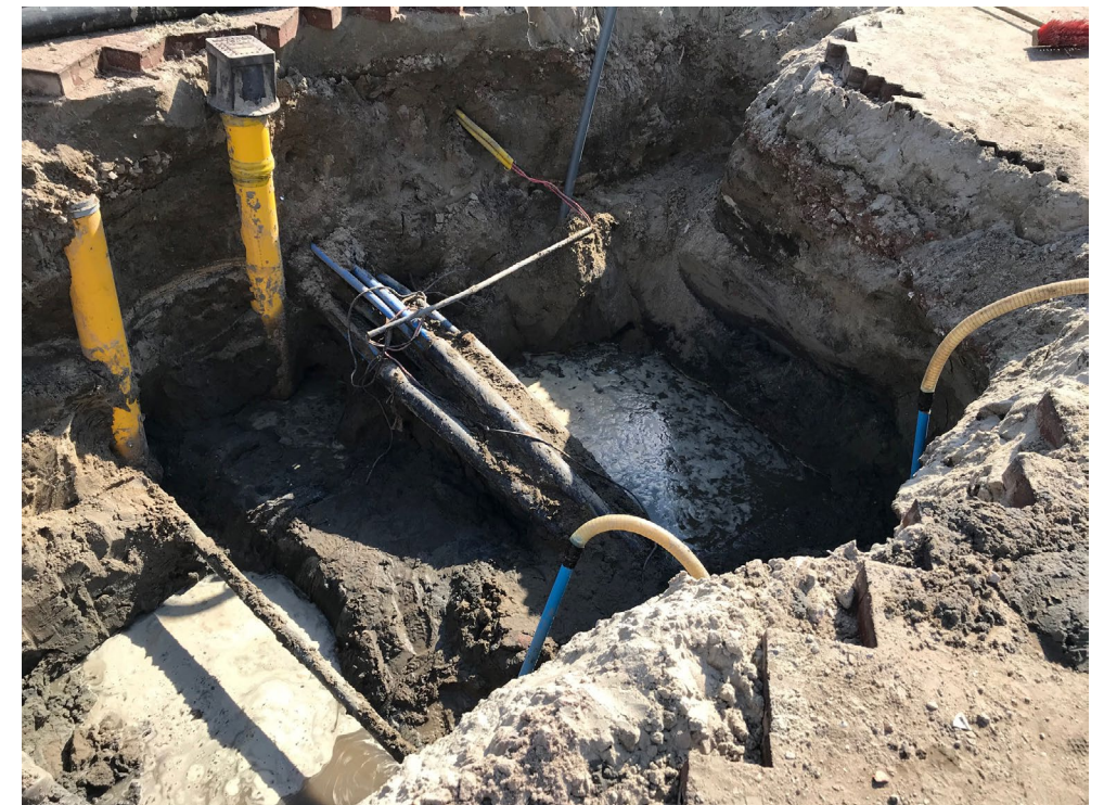
Foto: proefsluis ter plaatse van zinker voor het in kaart brengen van de kabels en leidingen
