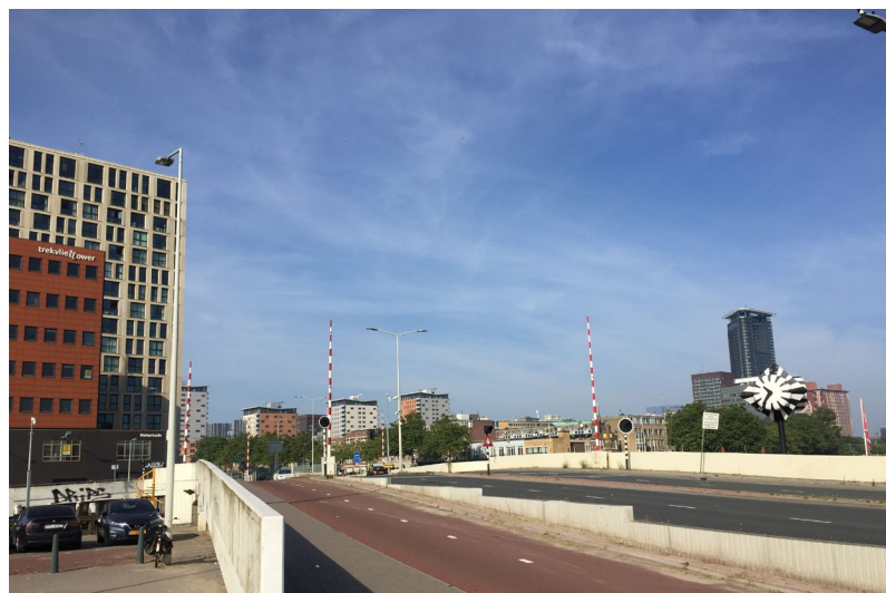
blik over de Trekvietsbrug richting het westen, de geluidsschermen zijn reeds verwijderd
